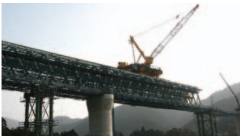
写真-12 宮川橋の架設時
