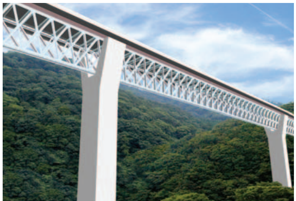
写真-14 三角断面ラチストラス橋の外観
