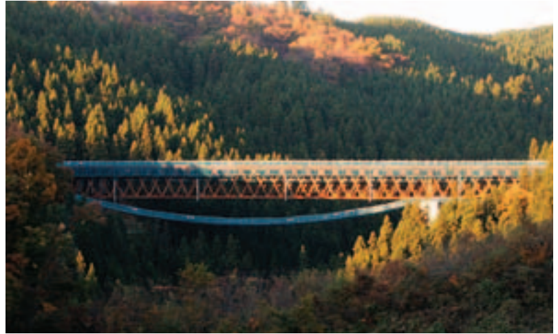
写真-13 閉合時の渡瀬橋
