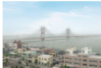
銚子大橋(施工中)
