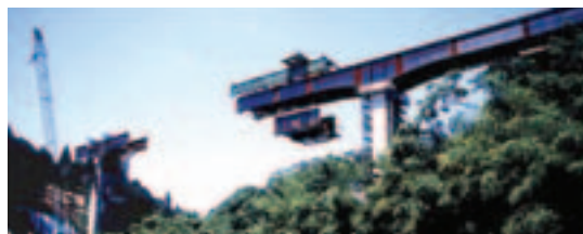
写真-6 TEGクレーン張出し架設
