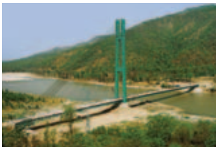
カルナリ川橋
