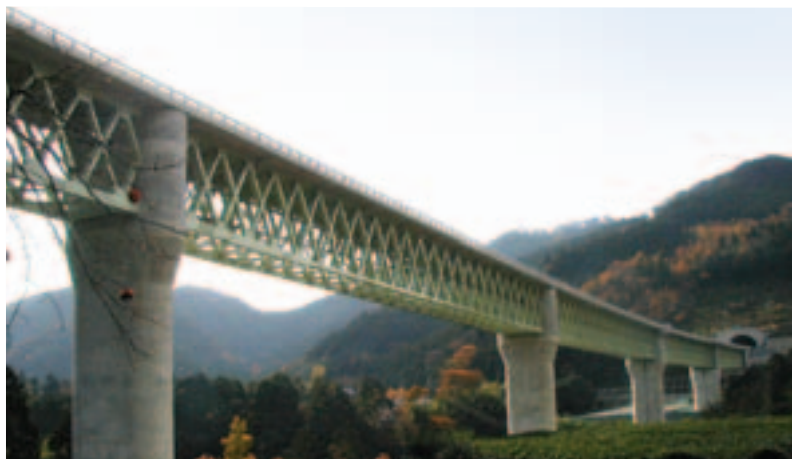
写真-11 宮川橋の完成写真
