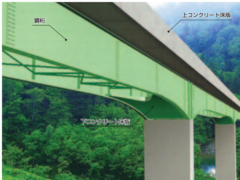
図-5 二重合成複合ラーメン橋の構造
