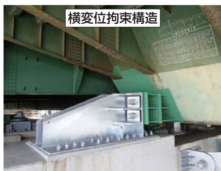
負反力対策構造・段差防止装置
