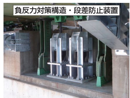
落橋防止装置（Kリンク）・縁端拡幅
