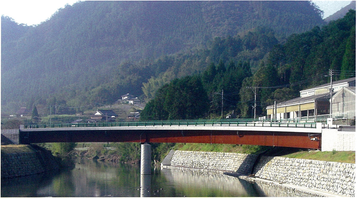
しん どう めき 新 洞 鳴 橋 (連続鉄桁橋)
