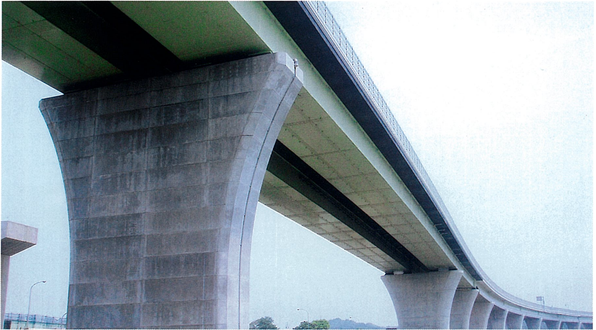
すずかかわ 鈴鹿川橋 (連続箱桁橋)
