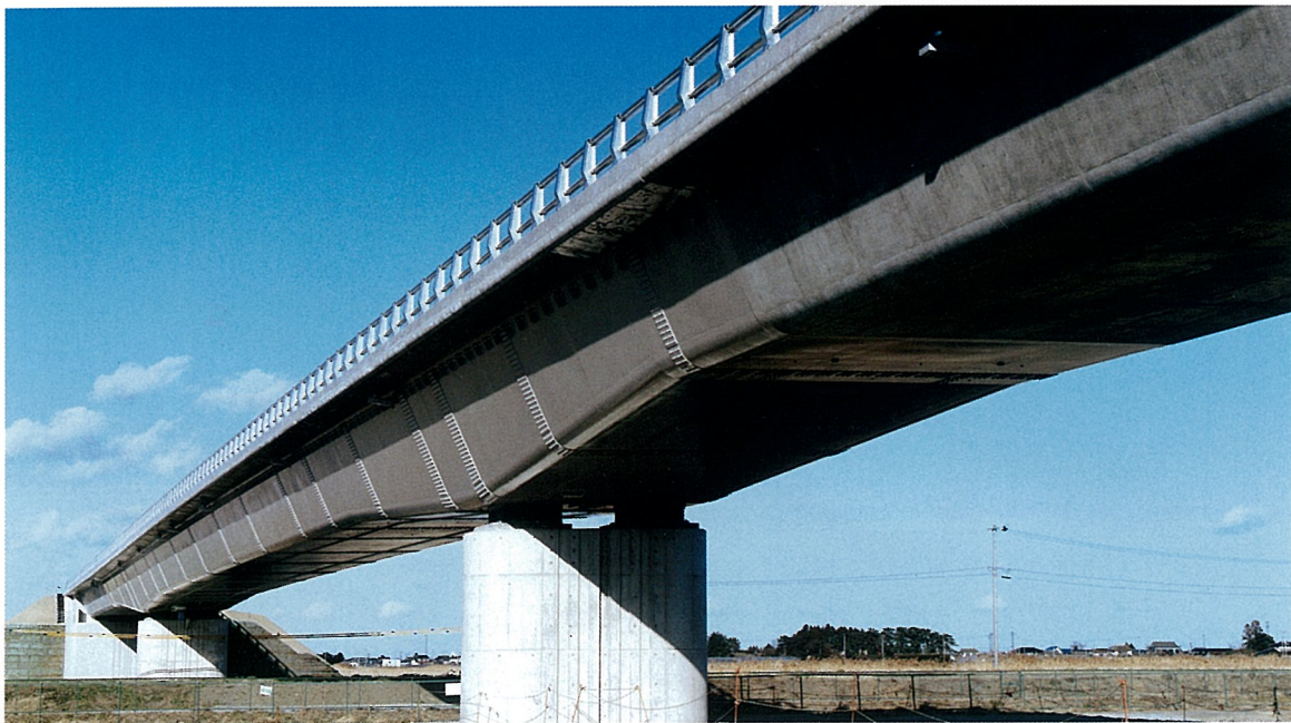
あぶみ かがわ 橋 (連続箱桁橋) (資料 178頁参照)
