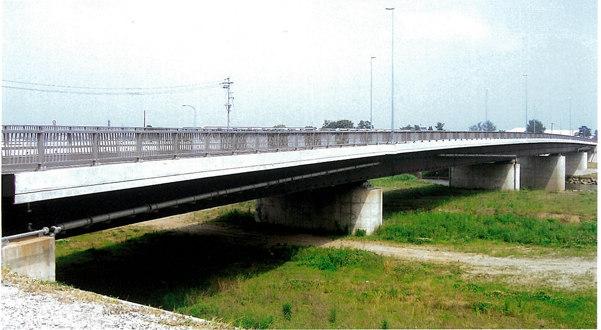
めい 明 治 橋 (連続箱桁橋)
