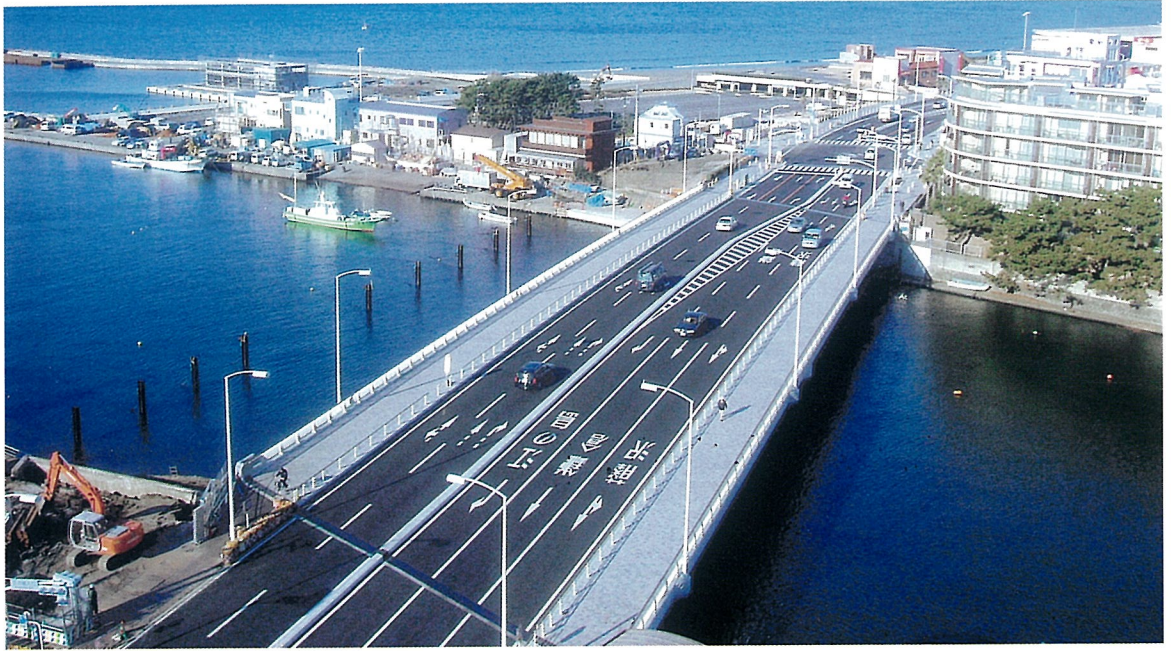
かた せ 橋 (連続箱桁橋) (資料 182頁参照)
