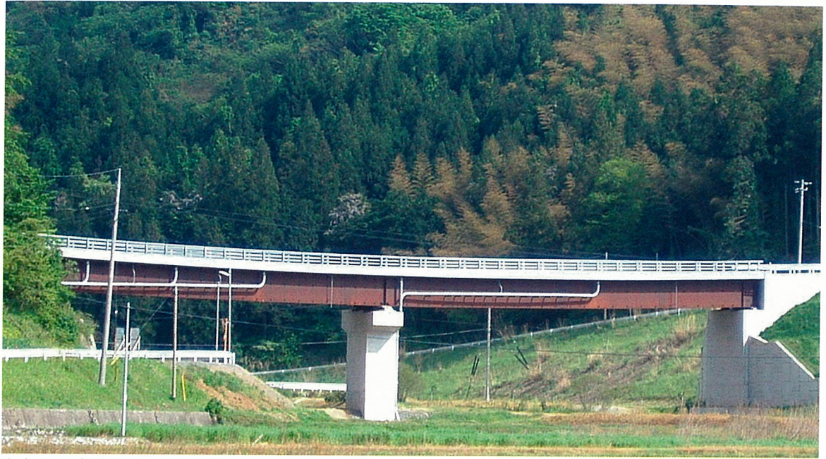
たねむら 種村大橋 (連続鈑桁橋)
