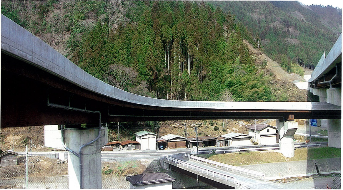
おみ 尾見ランプ橋 (連続箱桁橋)
