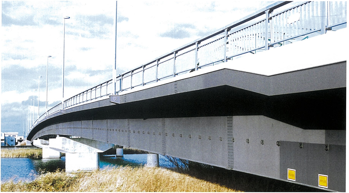
くらしきがわ 倉敷川橋 (連続箱桁橋)
