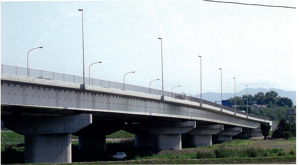
たいとう 碓東大橋 (連続箱桁橋)
