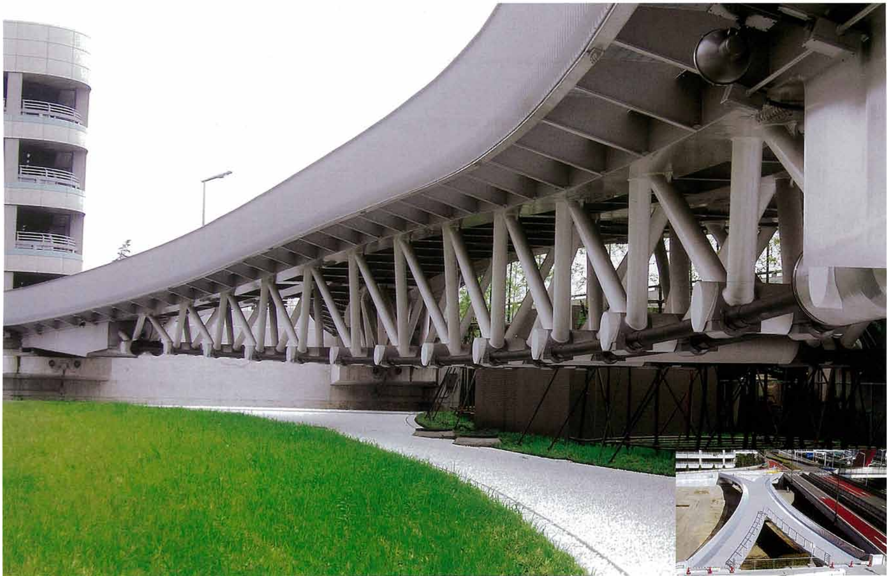
にしがわちゅうおうひろば 西側中央広場歩道橋 (その他の橋梁)
