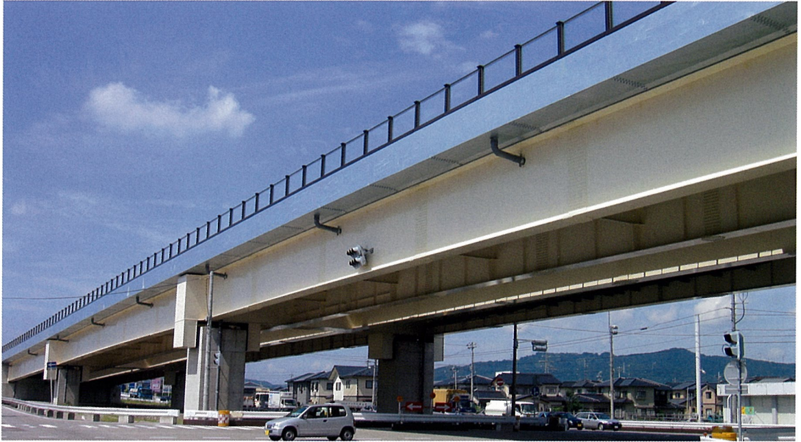
しもだ 下田立体橋 (連続鋼桁橋)
