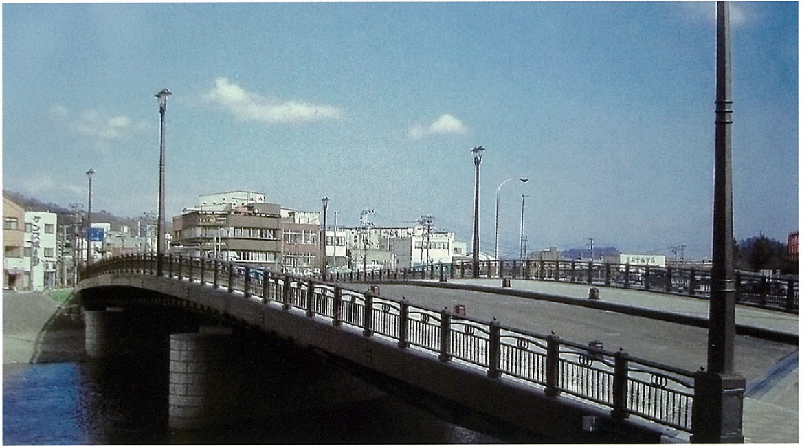
おお 大 わたり 渡 橋 (連続鋼桁橋) (資料 168頁参照)
