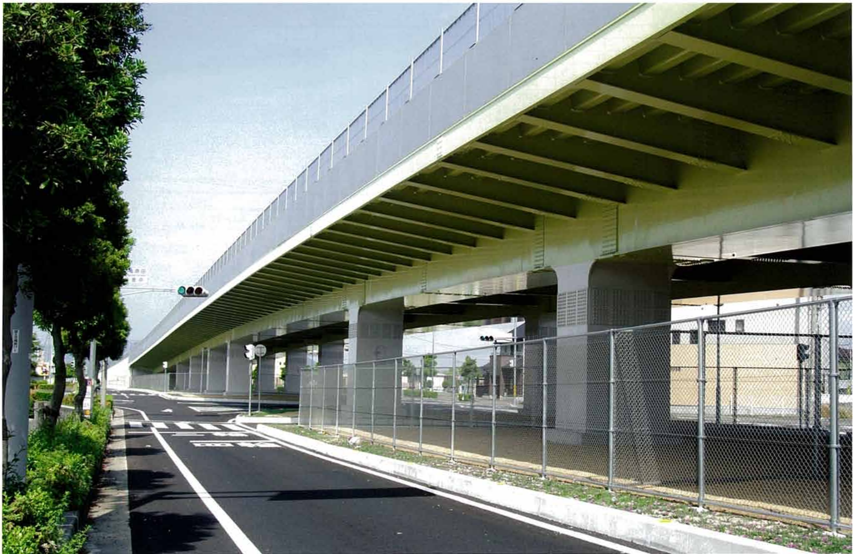
はら だ 原田高架橋 (ラーメン橋)
