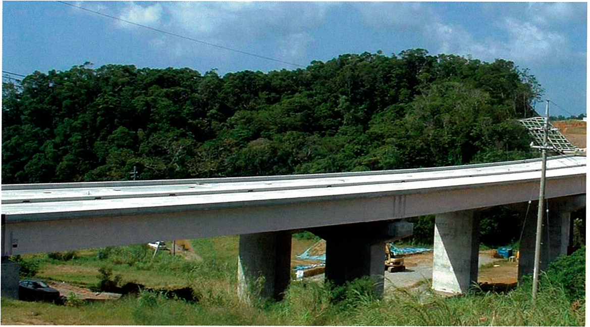
とまやま 渡真山橋 (連続鋼桁橋)
