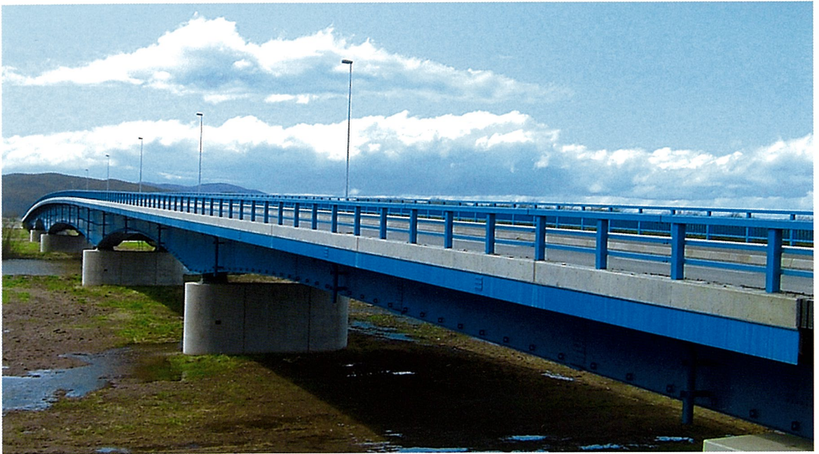
湖 響 橋 (連続箱桁橋) (資料 178頁参照)
