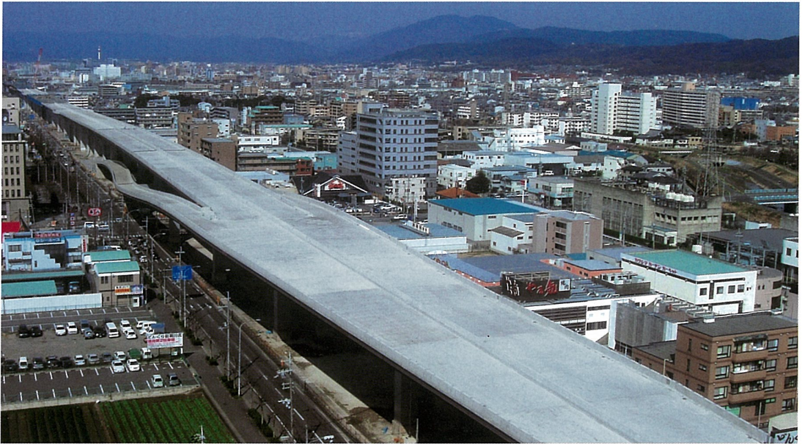
たけだだい 竹田第4工区 (ラーメン橋)
