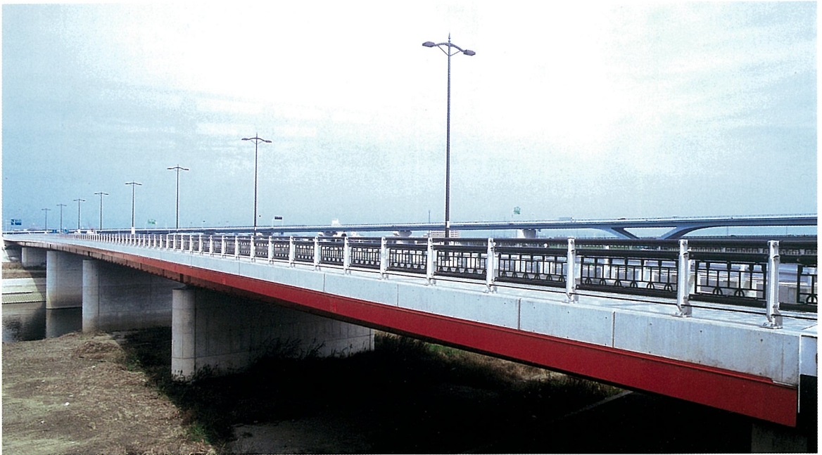
よどがわごこう 淀川御幸橋 (連続箱桁橋)
