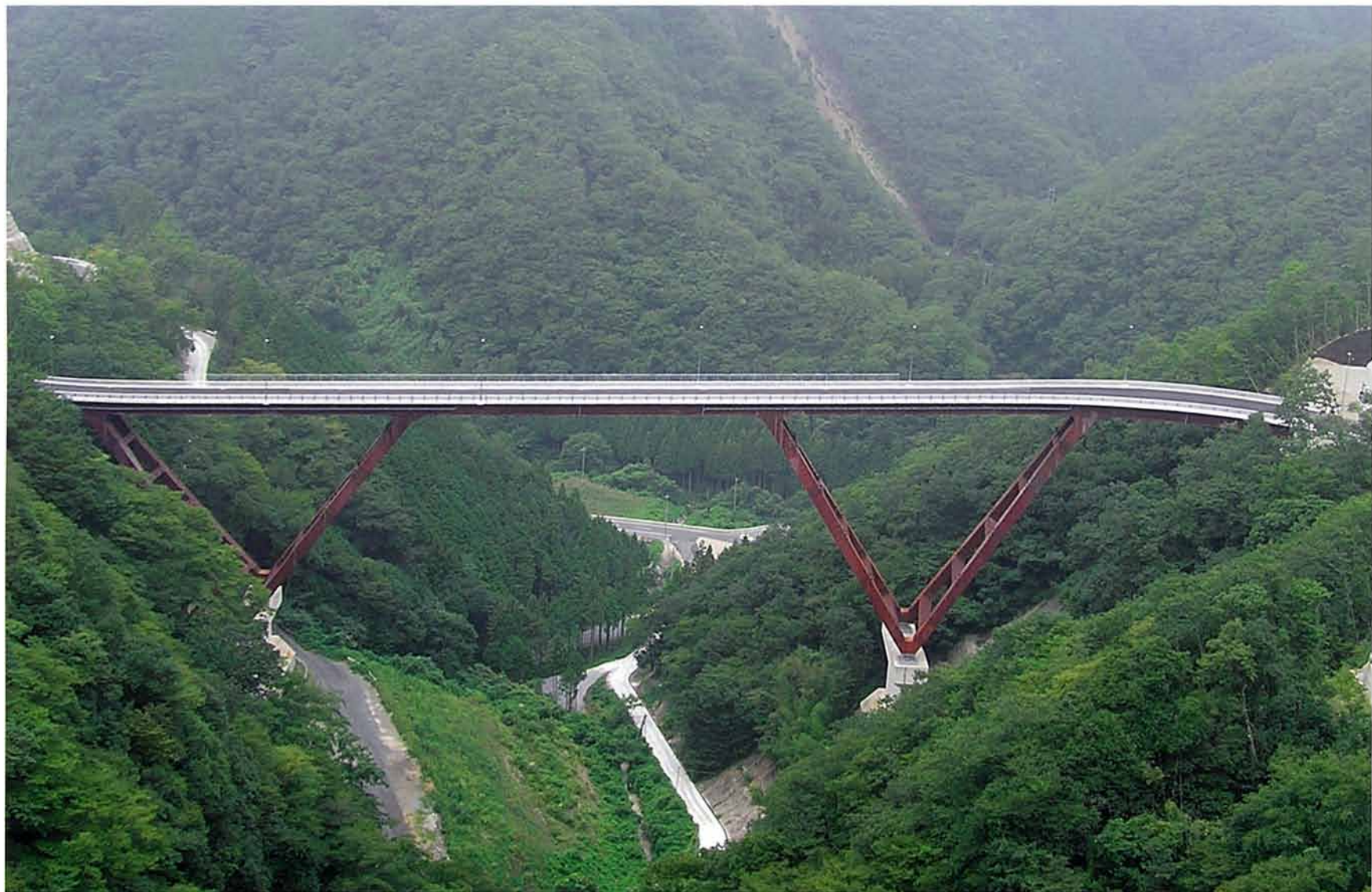
まる たき がわ 丸 滝 川 橋 (ラーメン橋)
