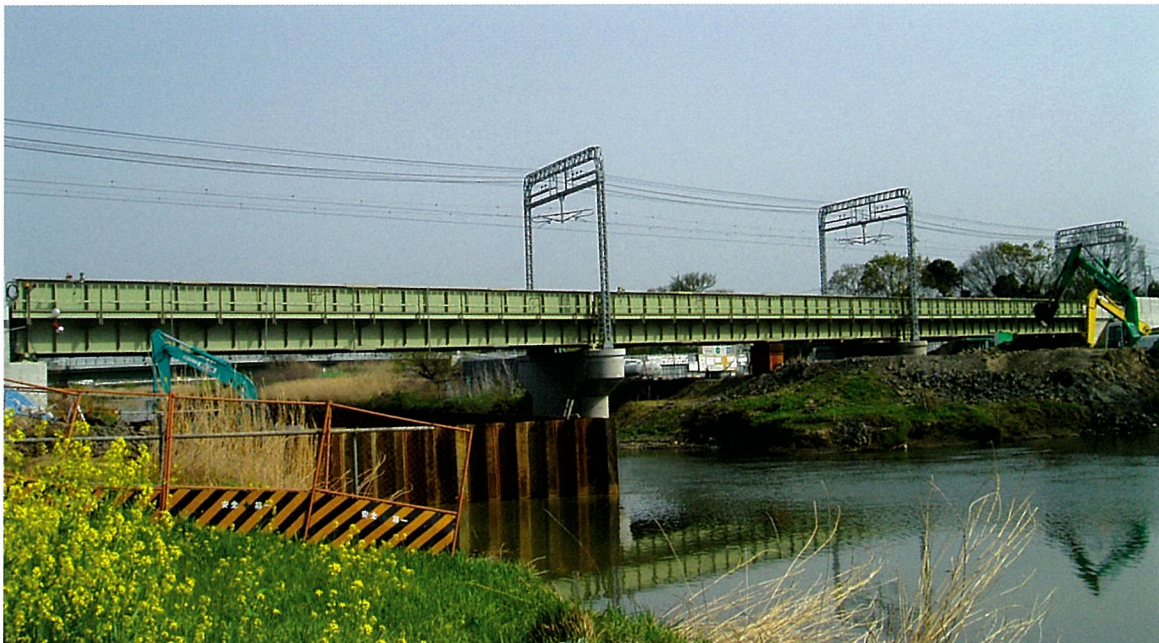
しまかわ 島川橋梁 (下路鉄桁橋)
