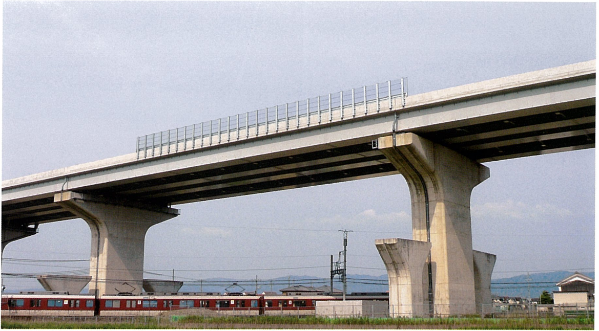
みやこ 宮古高架橋(P13~P16) (連続合成箱桁橋) (資料 186頁参照)
