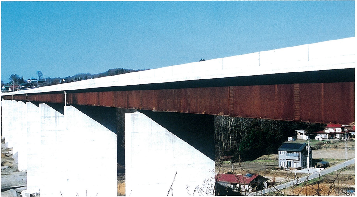
たちざわ 立沢大橋 (連続箱桁橋)
