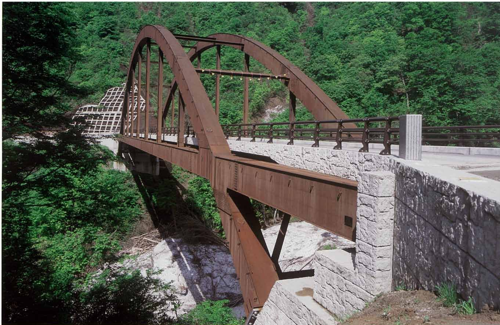
こしらぶさわ 小白布沢大橋 (ローゼ橋)
