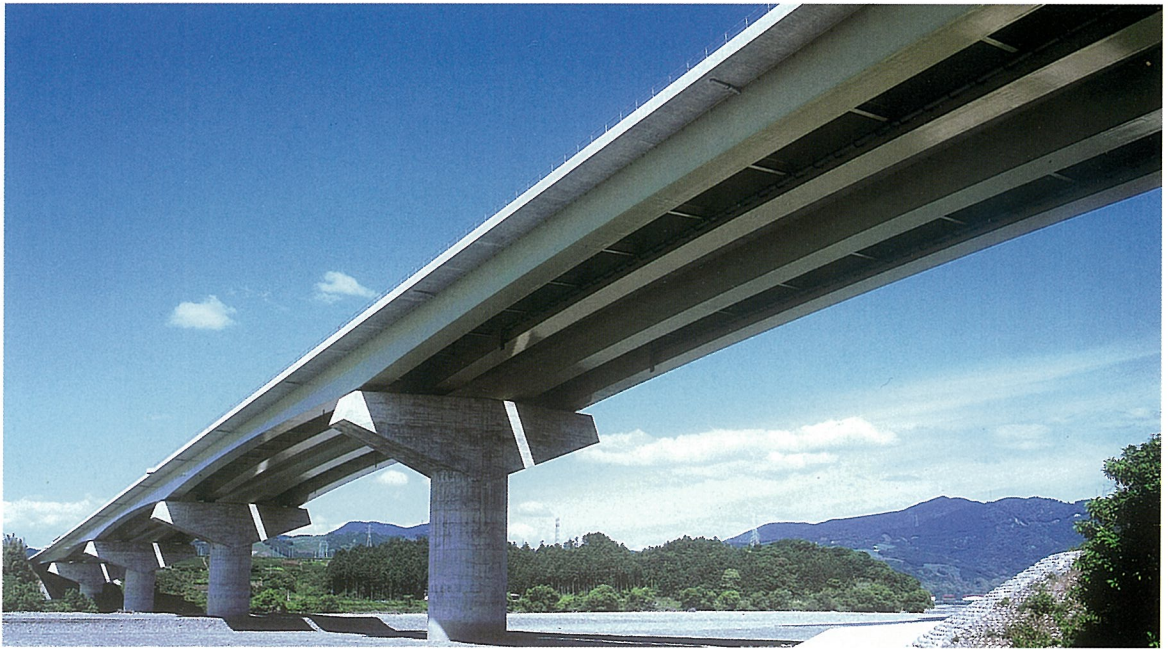
おおいがわ 大井川橋 (連続合成箱桁橋)
