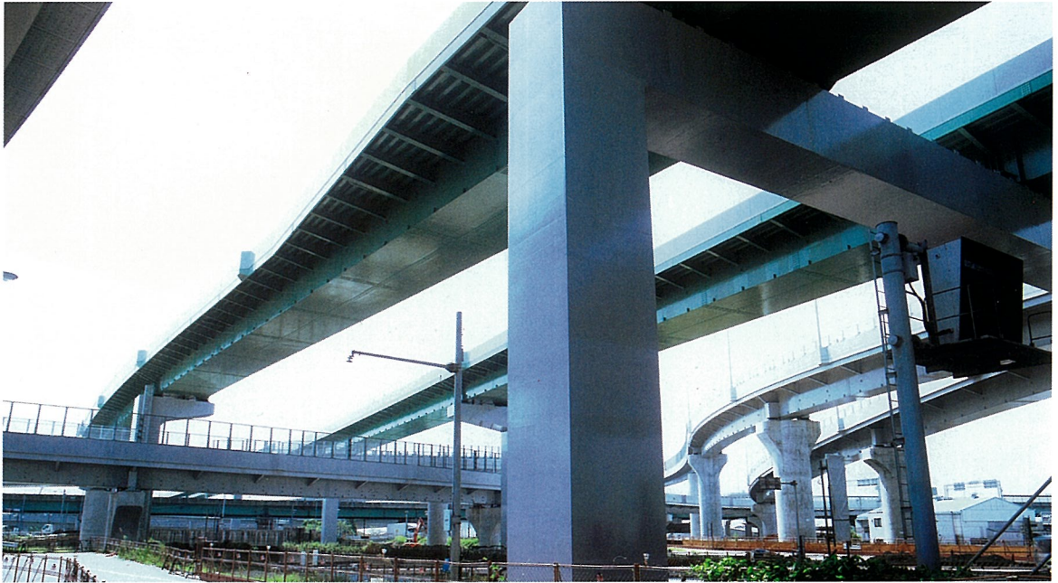
めい ぎ どう ろ 名岐道路 (本線橋P146~P2) (連続箱桁橋) (資料 178頁参照)
