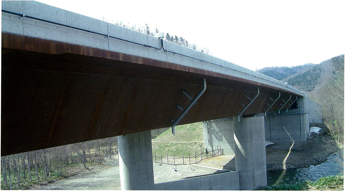
まる なか 橋 (連続合成箱桁橋)
