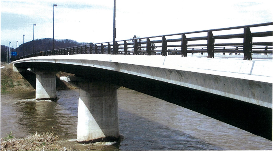
みかのせ 三ヶ瀬橋 (連続箱桁橋)
