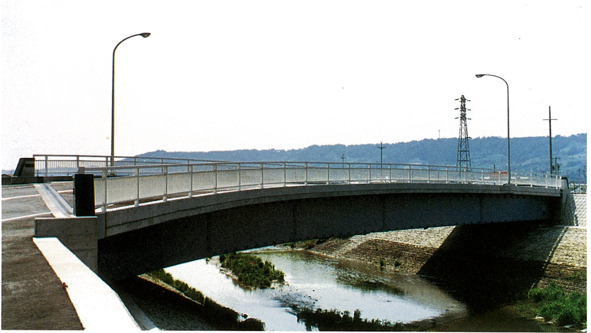
ちゆう 中央 ばし 橋 (単純箱桁橋)
