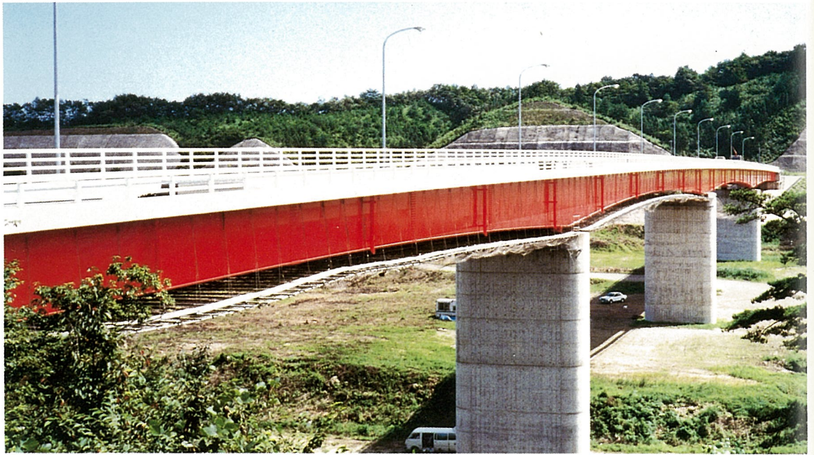
ななつもりおおはし 七ツ森大橋 (連続箱桁橋)
