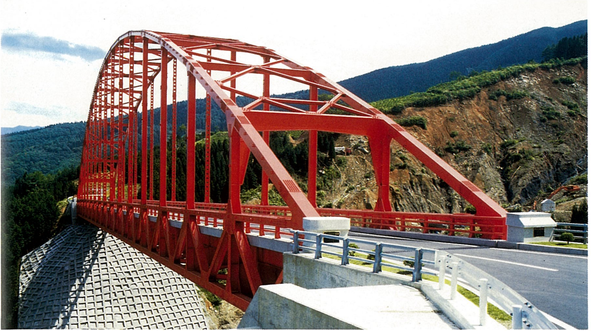
おくしいばやし橋 (ランガートラス橋)
