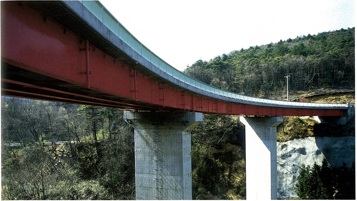
ごまめおおはし 胡麻目大橋 (連続鋼桁橋)
