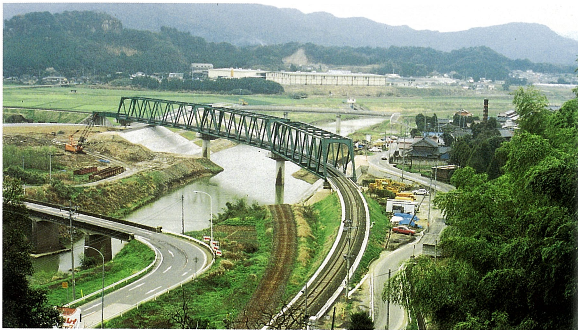
くぼかわきょうりょう 久保川橋梁 (下路トラス橋)
