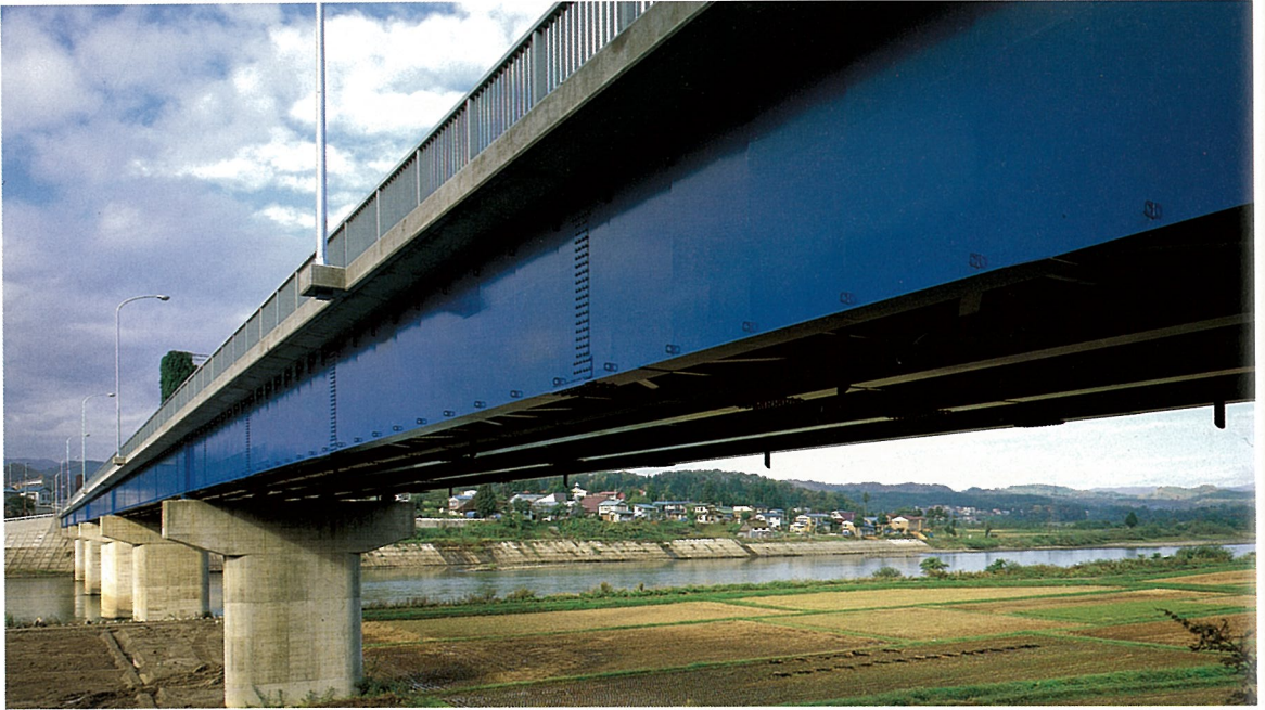
からす 烏 川 橋 (連続鋼桁橋)
