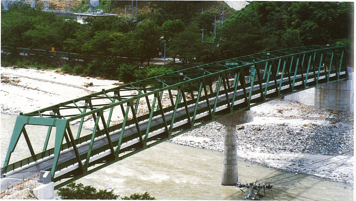
ひら 平 おか 岡 ばし 橋 (連続トラス橋)
