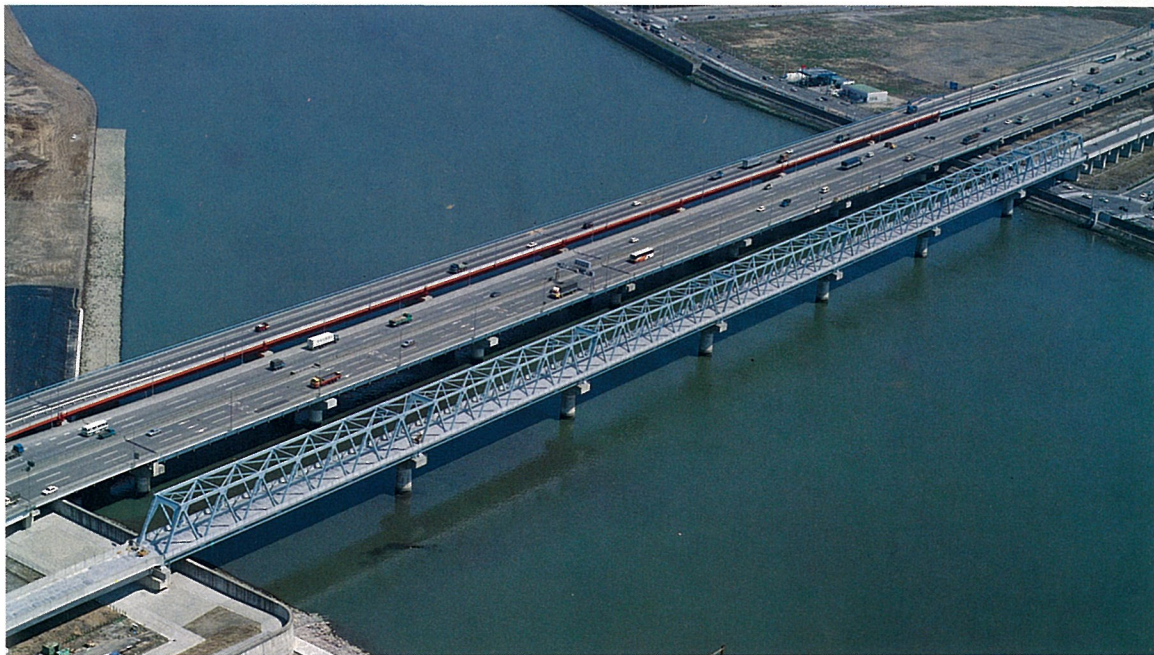
えどがわきょうりょう 江戸川橋梁 (下路トラス橋)
