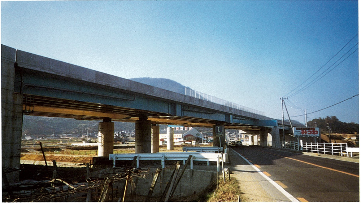
よし 吉 原 ばし 橋 (連続鋼桁橋)
