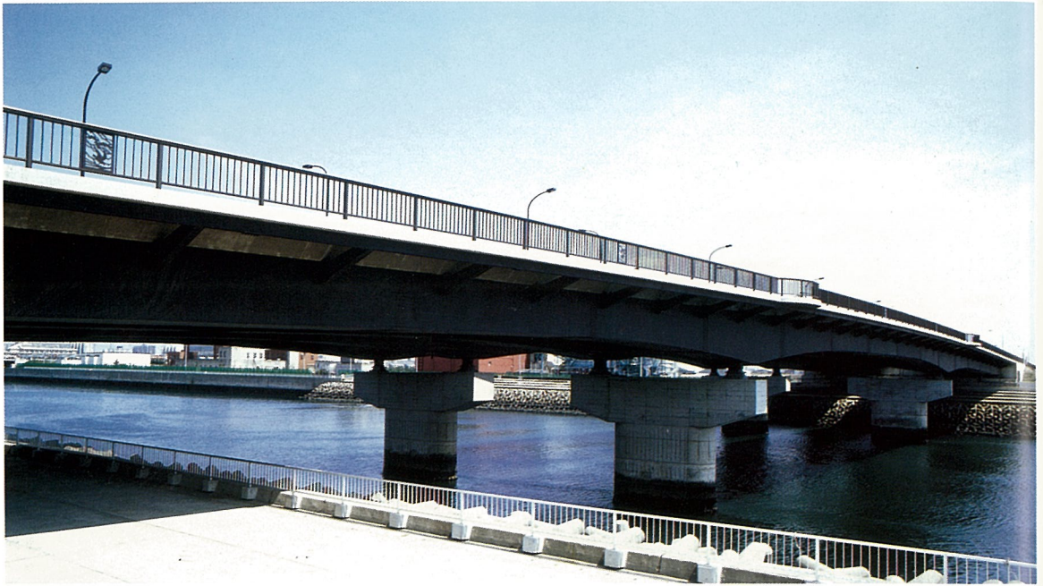
み はま おお はし 美 浜 大 橋 (連続箱桁橋)
