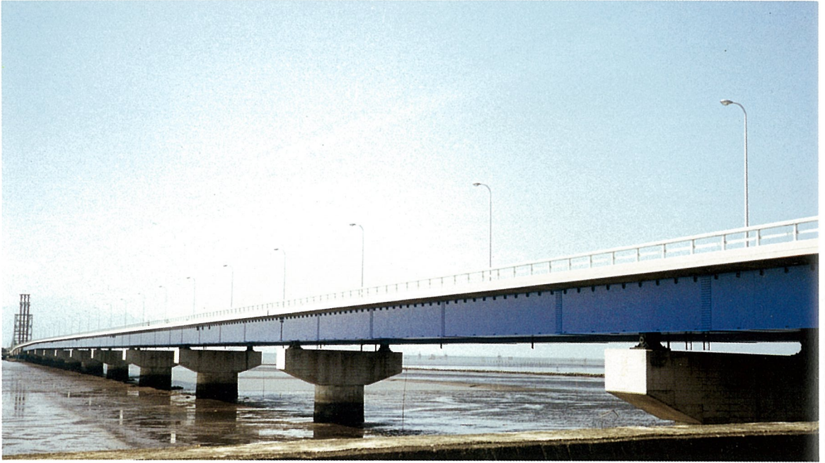
くまもとこうおおはし 熊本港大橋 (連続箱桁橋)
