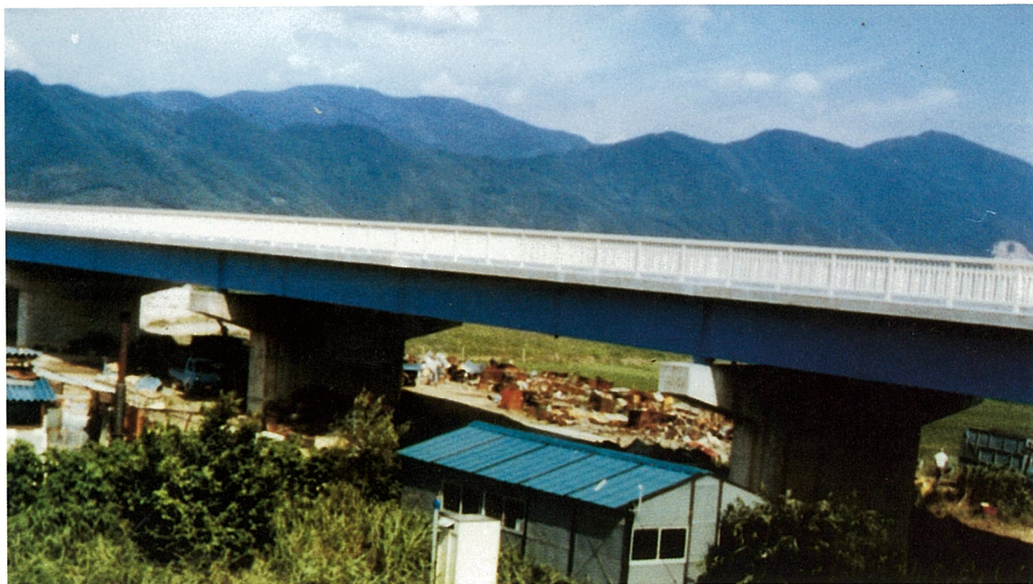
へい 和 ばし 橋 (連続鋼桁橋)
