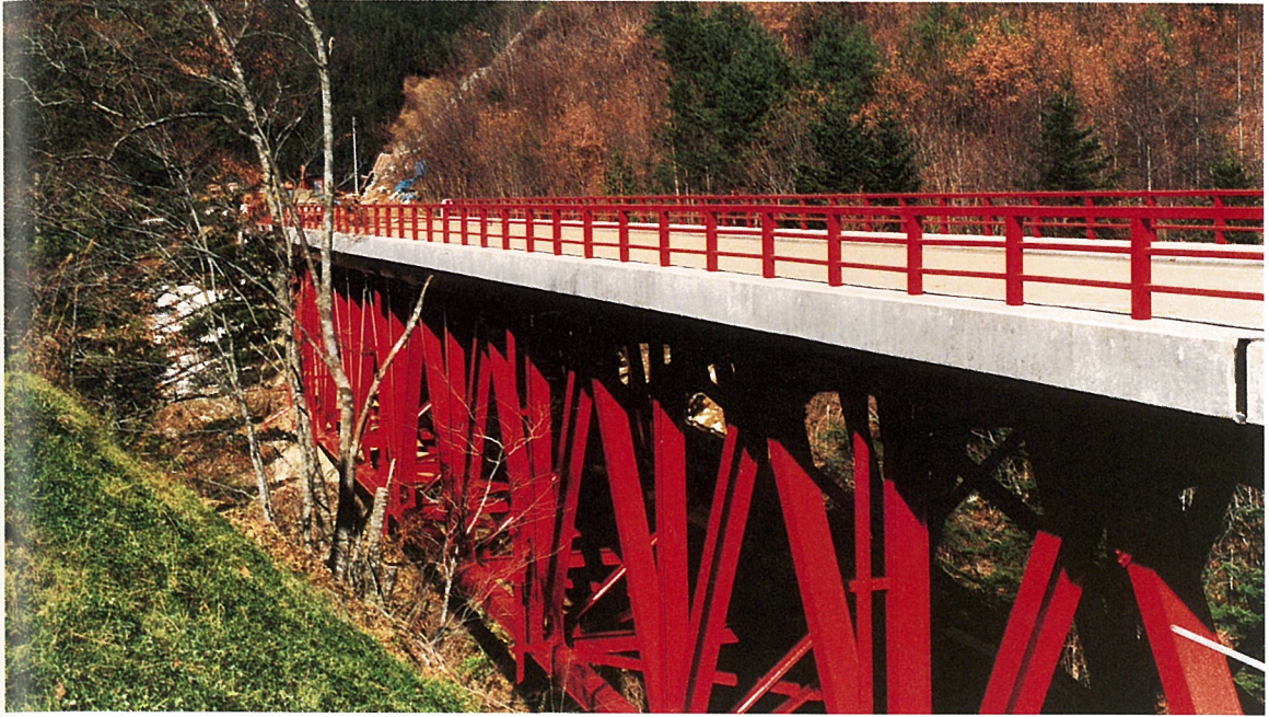
とちほらばし 栃 洞 橋 (単純トラス橋)
