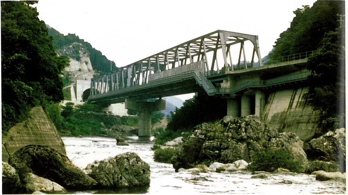
だいなないがわきょうりょう 第3穴内川橋梁 (下路トラス橋)
