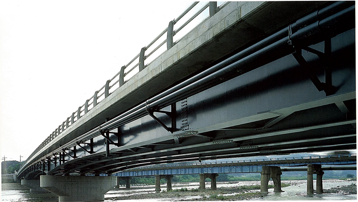
さいと 戸 ばし 橋 (連続鋼桁橋)
