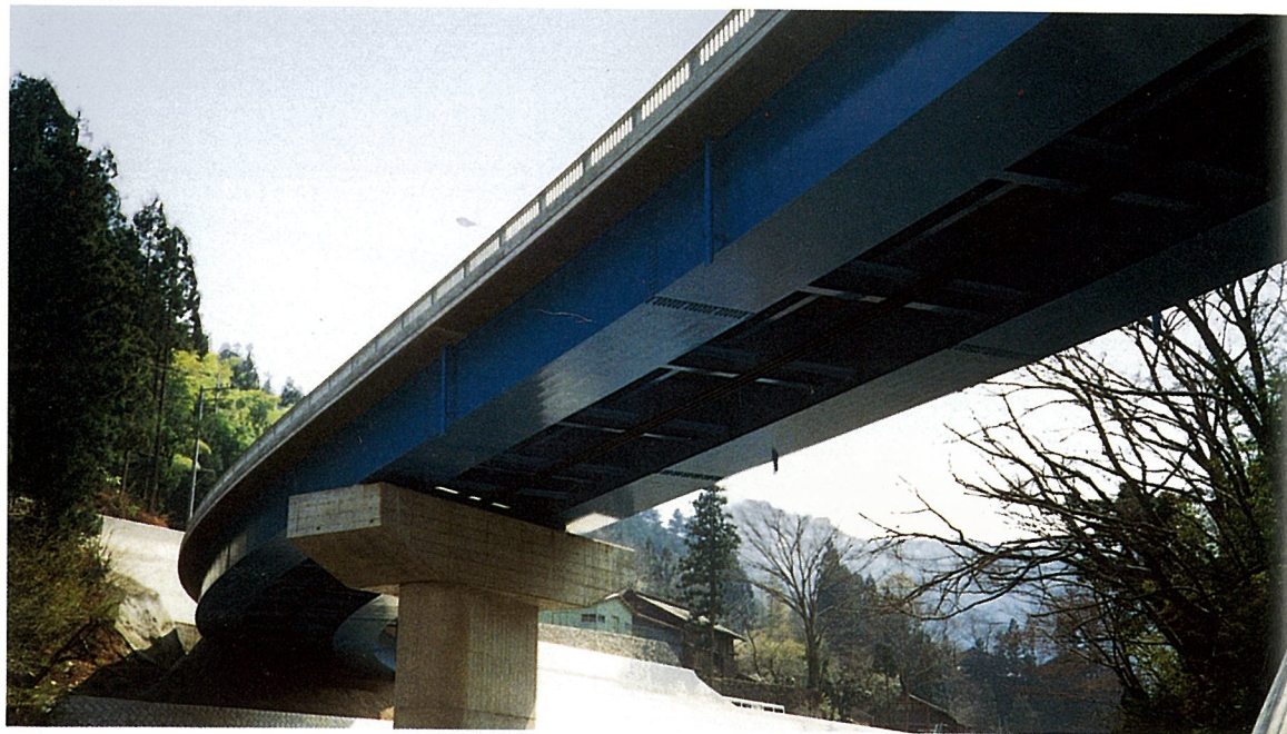
こ だいら ばし 橋 (連続箱桁橋)
