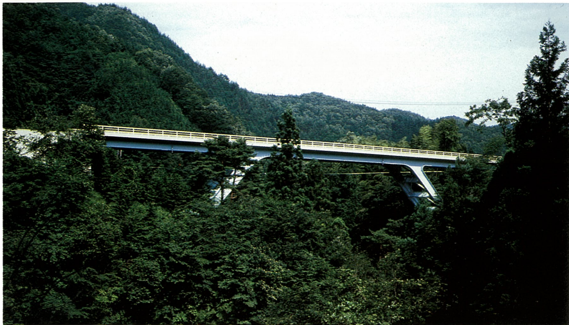
おお わた ど ばし 大 渡 戸 橋 (ラーメン橋)
