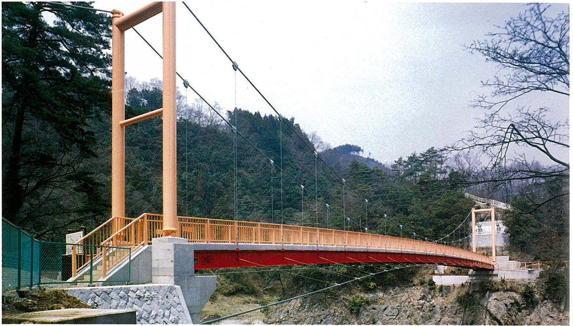
べん てん ばし 橋 (吊橋)
