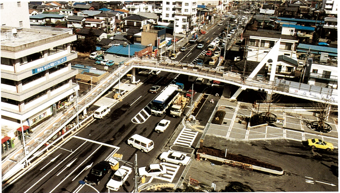
あだちくやくしよまえほどうきよう 足立区役所前歩道橋 (斜張橋)
