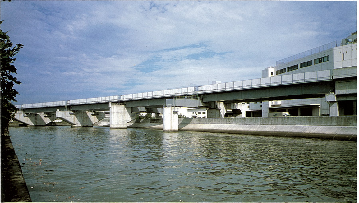
ふたまたうんがきょうりょう 二俣運河橋梁 (合成箱桁橋)
