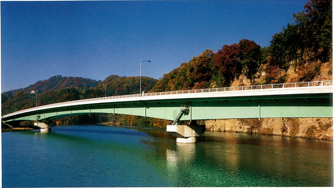
だい あん じ ばし 大安寺橋 (連続箱桁橋)
