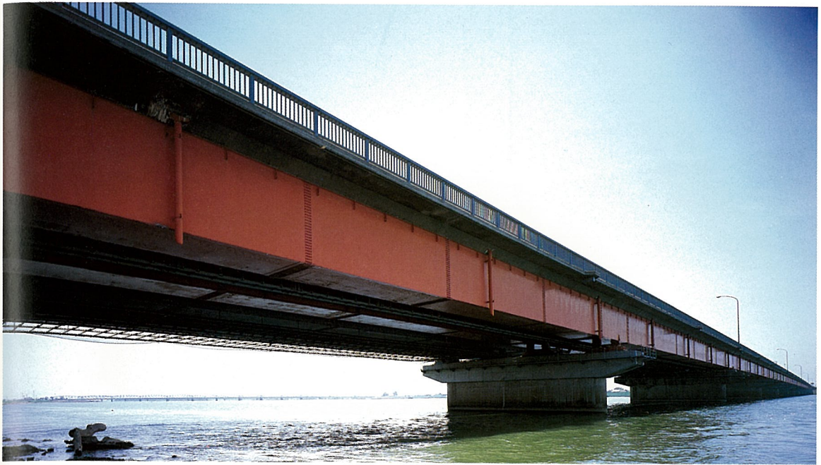
あがのかわおおはし 阿賀野川大橋 (連続箱桁橋)
