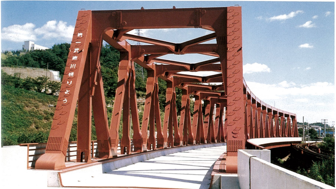
だい 一 む こ がわきよりよ 第 1 武庫川橋梁 (下路トラス橋)
