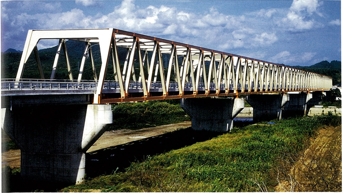
刈和野橋 (連続トラス橋)
