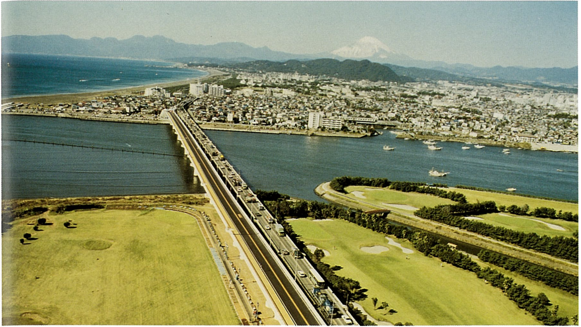
しよ はん おお はし 湘 南 大 橋 (連続箱桁橋)
