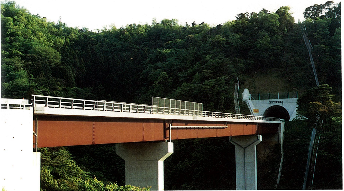
かき 柿 け 谷 ばし 橋 (連続鋼桁橋)
