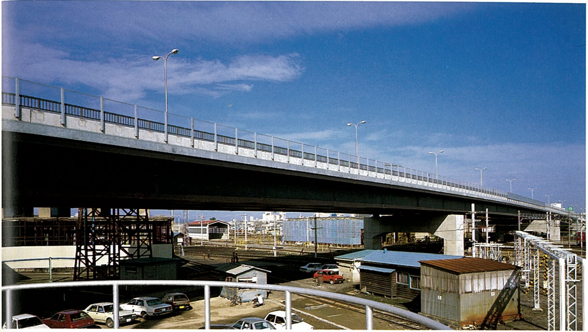
あおもりちゅうおうおおはし 青森中央大橋 (連続箱桁橋)
