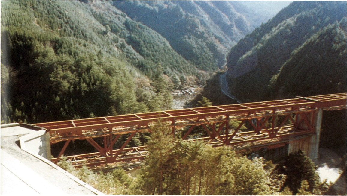
なか お だに ばし 中 尾 谷 橋 (単純トラス橋)
