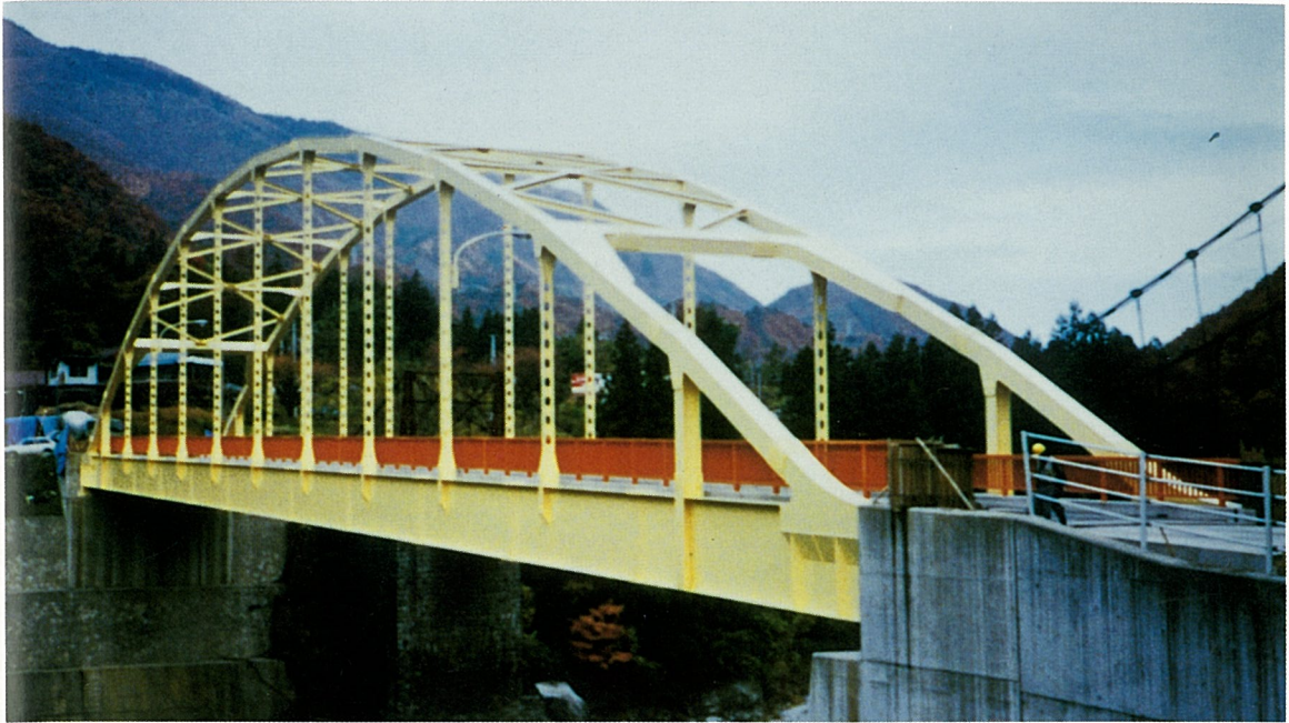
もも やま はし 桃 山 橋 (ランガー桁橋)
