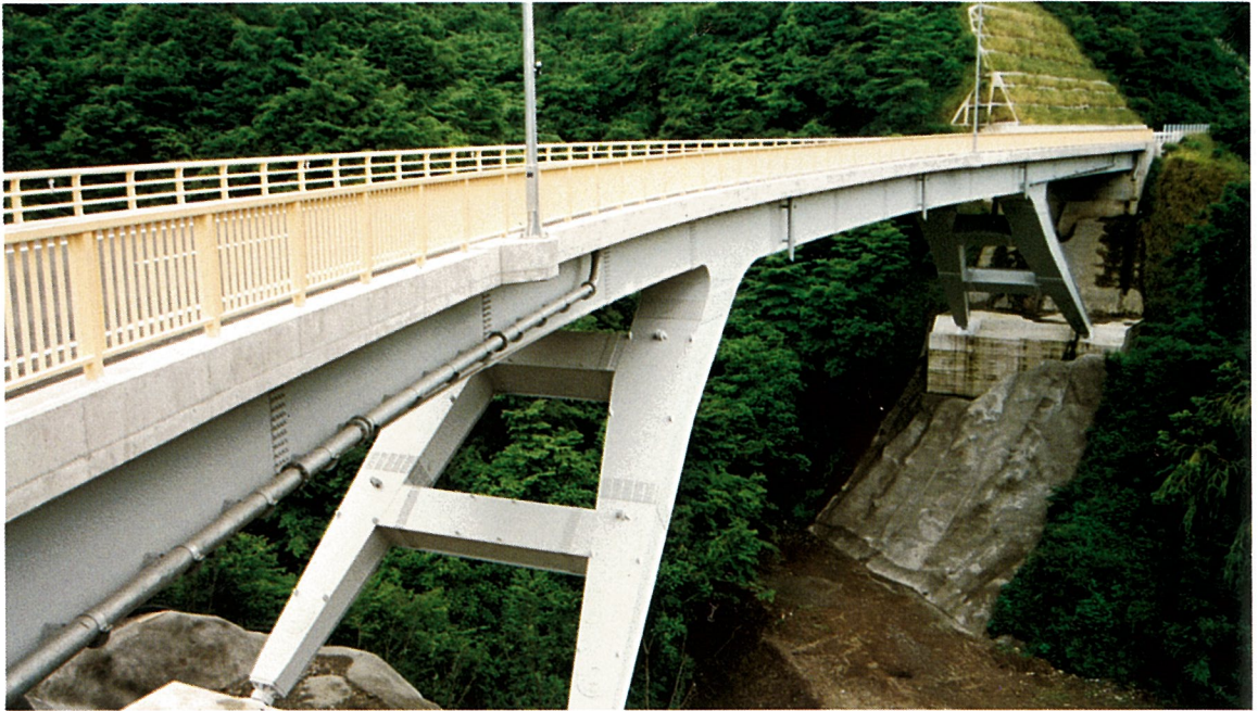
おい ざわ ばし 橋 (ラーメン橋)
