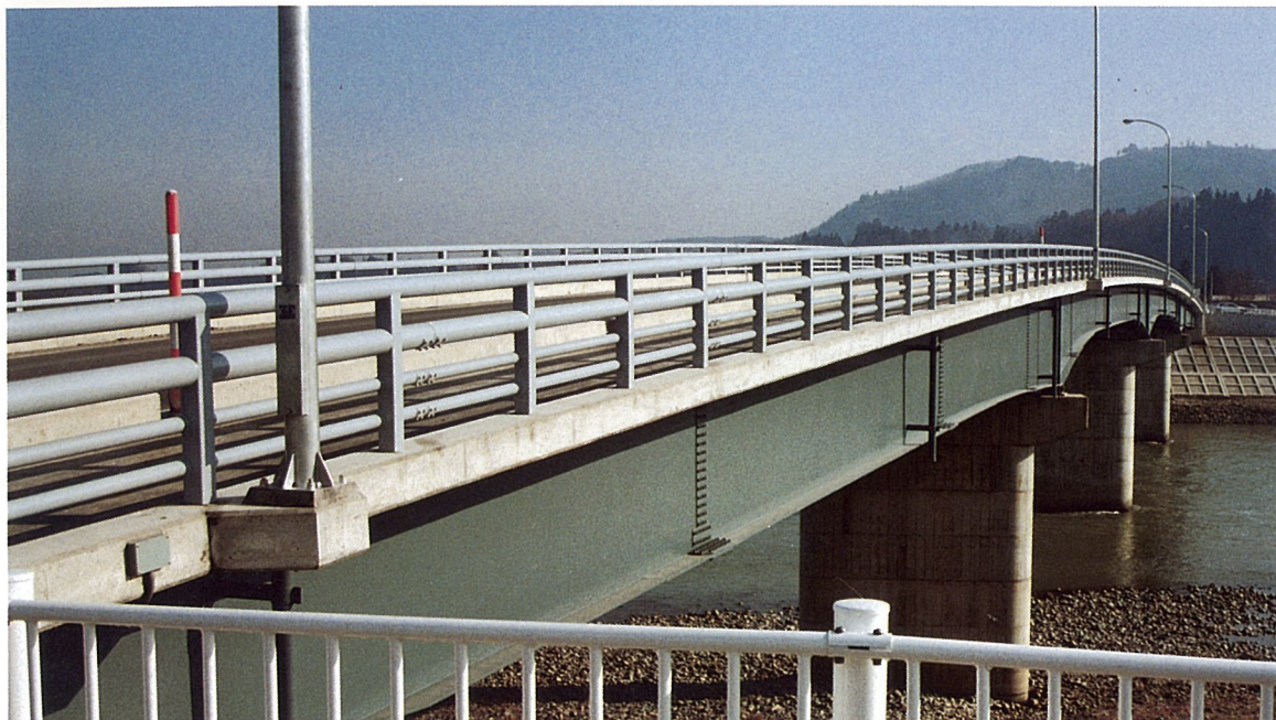
かた 片 門 橋 (連続鋼桁橋)
