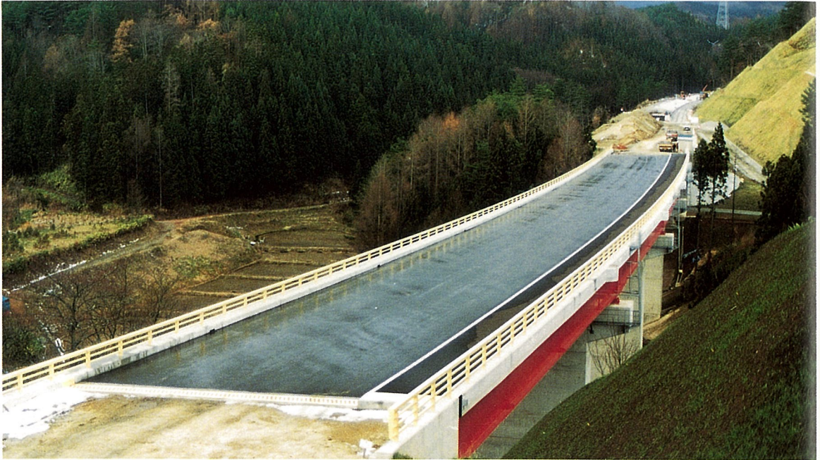
と かも におお はし 戸 門 大 橋 (連続鋸桁橋)
