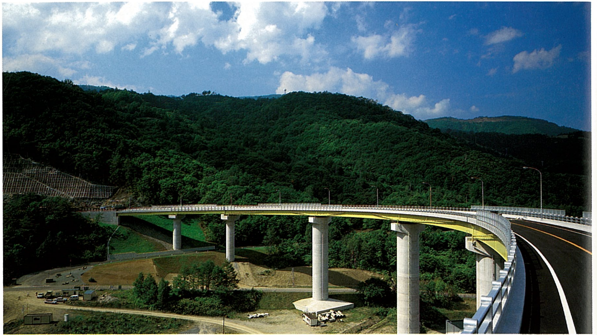
あさりおおはし 朝里大橋 (連続箱桁橋)
