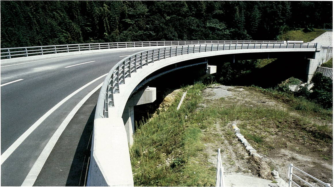
くりかわおおはし 栗川大橋 (単純箱桁橋)
