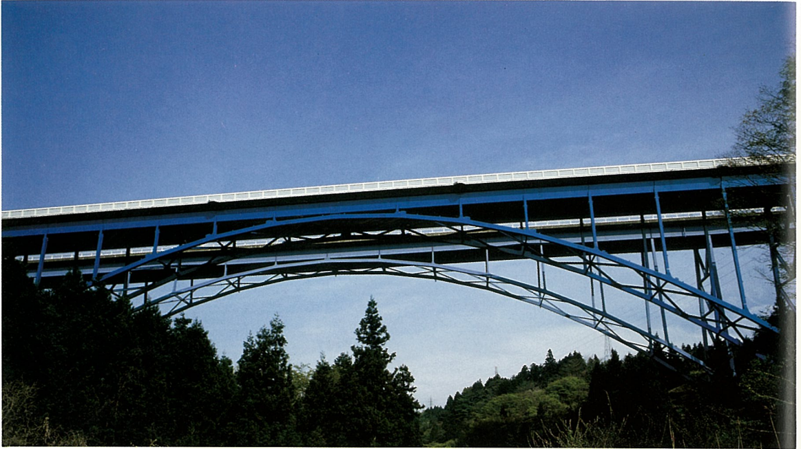
す 須 川 が わ ば し 橋 (ランガー桁橋)
