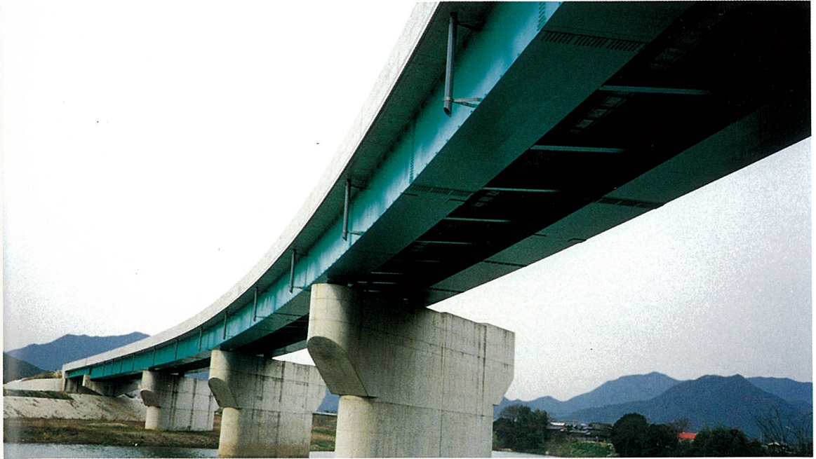
か 古 川 橋 (連続箱桁橋)
