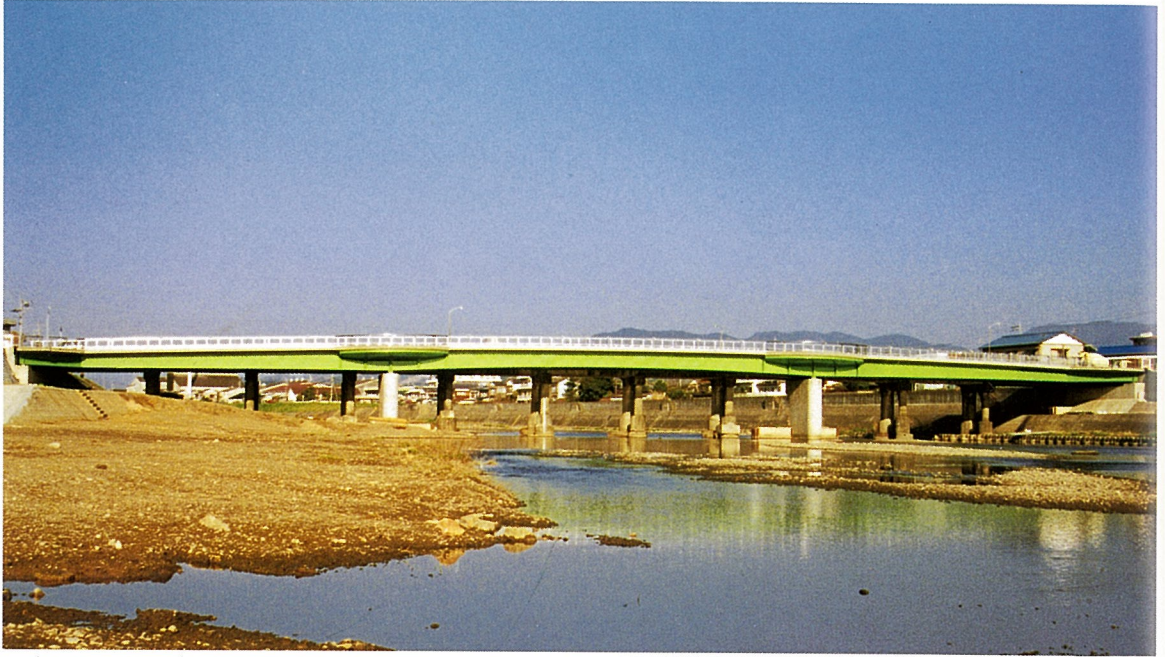
しんつきばし 新月橋(I期) (連続鉄桁橋)
