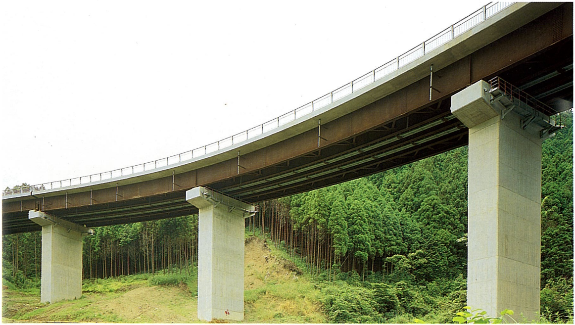
よこ 横 お 尾 橋 (連続鋼桁橋)
