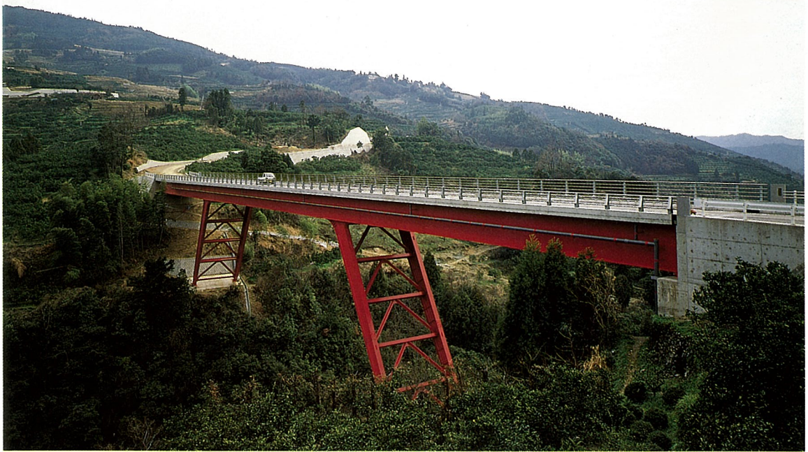
ご みよう おお はし 五 明 大 橋 (ラーメン橋)
