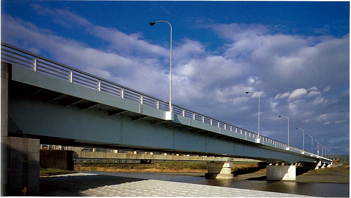
むかわおおはし 鶴川大橋 (連続箱桁橋)
