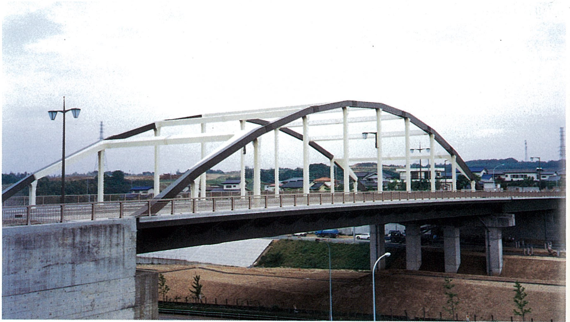
みなみ おお さわ おお はし 南 大 沢 大 橋 (ランガー桁橋)
