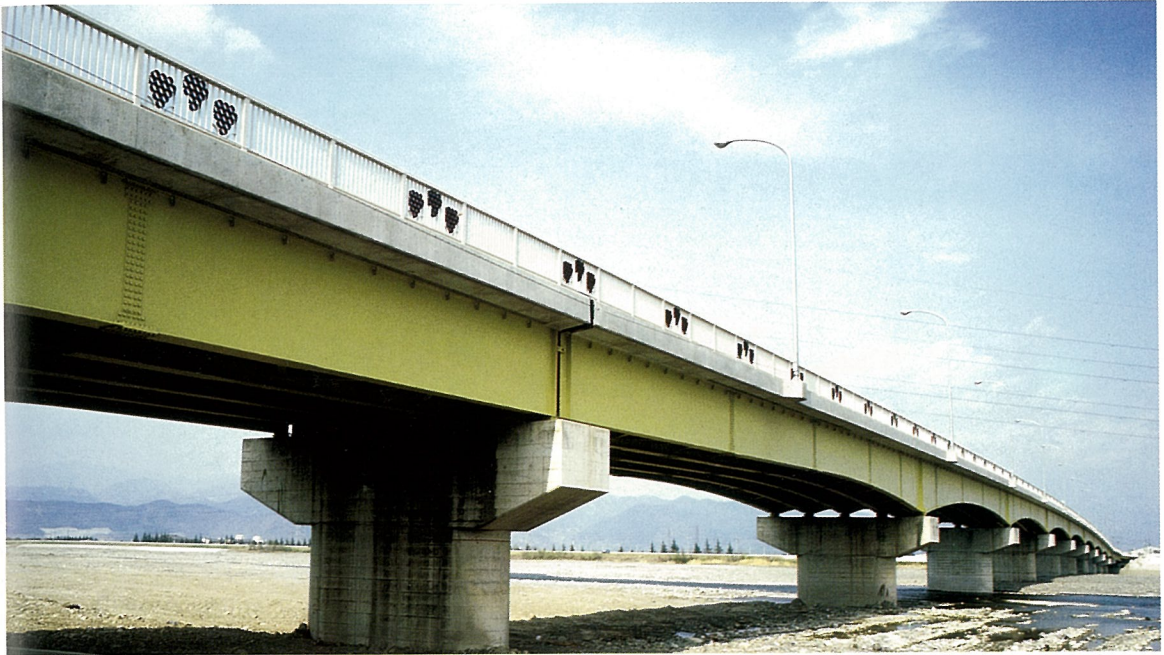
かいこくばし 開国橋(I期) (連続鉄桁橋)
