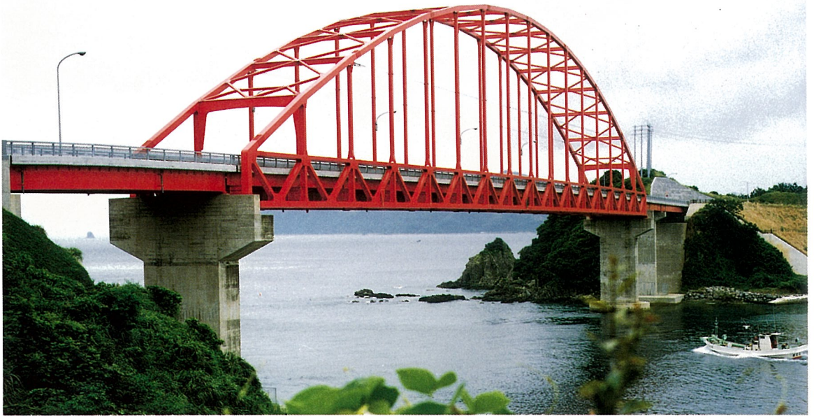
かばしま おお はし 樺 島 大 橋 (ランガートラス橋)
