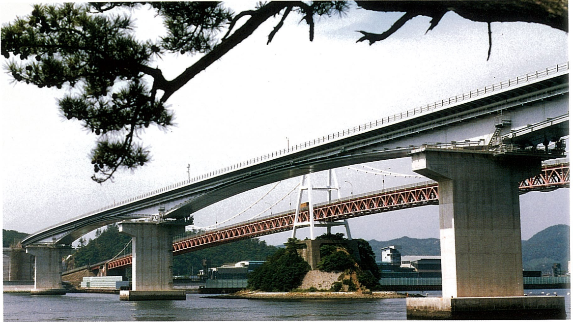
むらやしばし橋 (連続箱桁橋)
