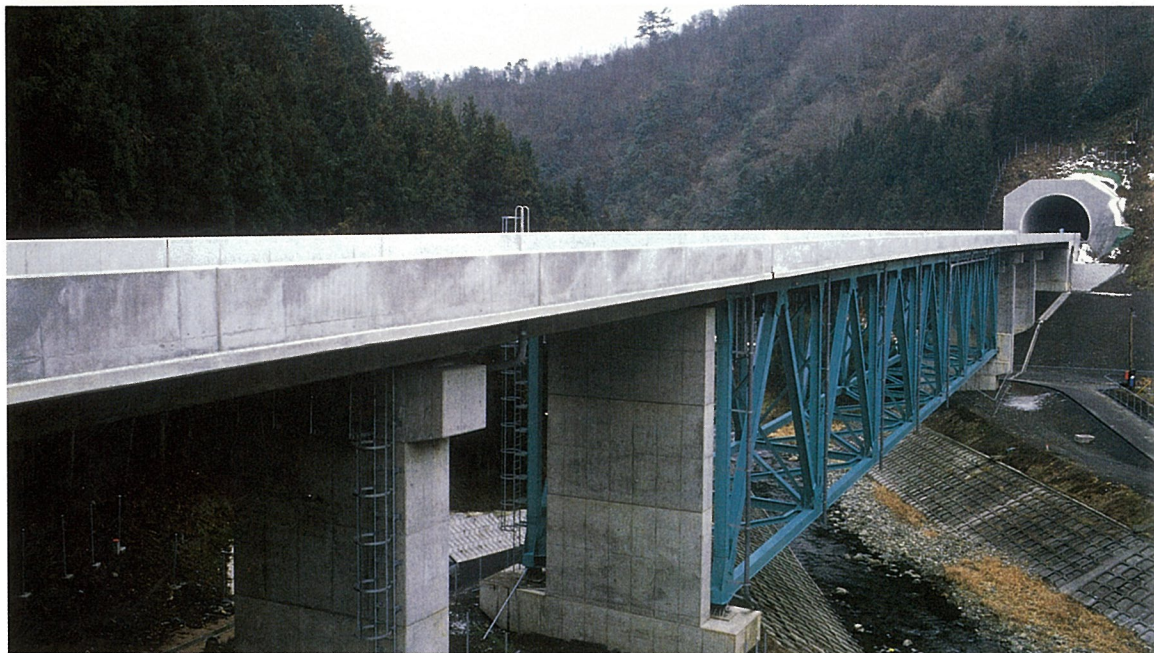
しま じ がわ ばし 島 地 川 橋 (単純トラス橋)
