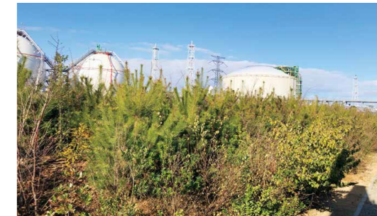
△ 福島天然ガス発電所での在来種を用いた緑化工事
