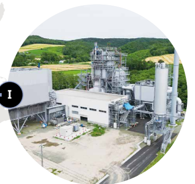
網走バイオマス発電所 2号機・3号機
