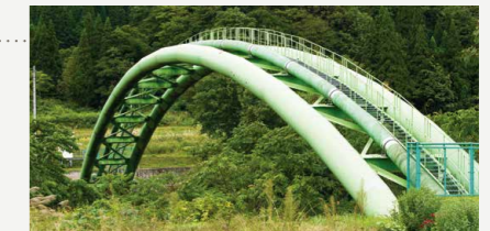
△ 新潟・仙台間ガスパイプライン
