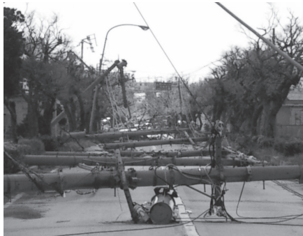
平成15年台風14号後の宮古島(沖縄県宮古事務所提供)
