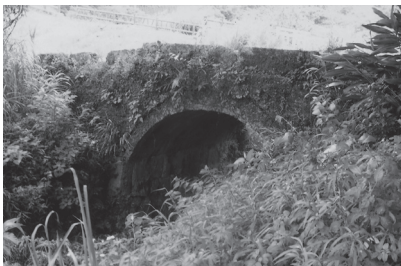
下流部から見た比地川橋(現在)
