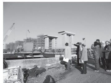
日光川水閘門改築工事現場
