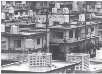
自衛手段の屋上タンク
