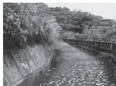
壁面石張りりと散策路の現況
