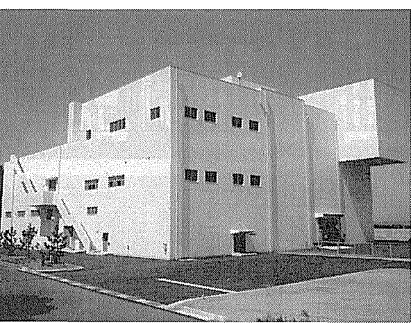
低レベル廃棄物の高減容処理施設の一部を構成する保管棟
