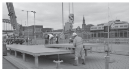
土台の設置状況（HPより）
