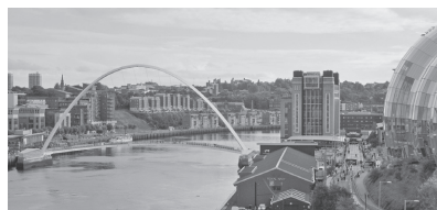
会場全景 川の左に走幅跳、 川の右の高い建物の 前の広場に棒高跳、 横の道路に直走路を 設置走路
