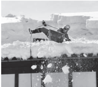
図2 危険な雪下ろし作業
