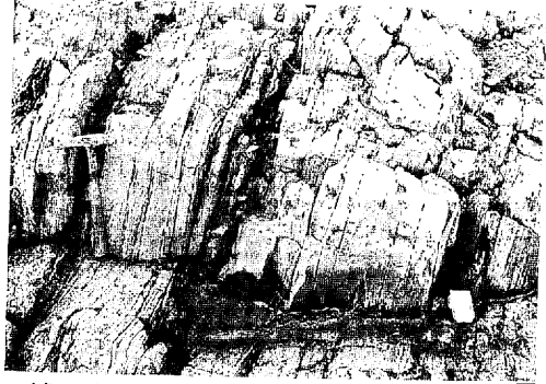
城ヶ崎 節理の著しい溶結凝灰岩
