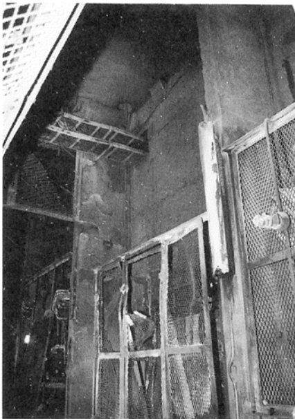
写真3 OT1 ケーブルヘッド付近の状況
