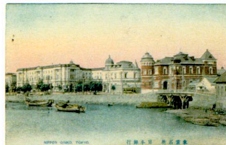
<明治期> 一石橋方面からみた日本銀行・東京火災保険会社
