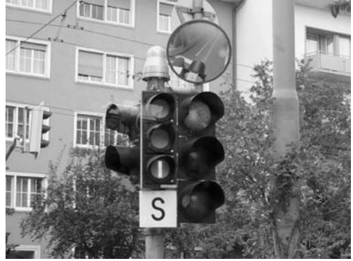
写真 - 5 トラムに対する優先信号現示 (左側がトラムに対する進行現示、 右側は自動車に対する停止現示)
