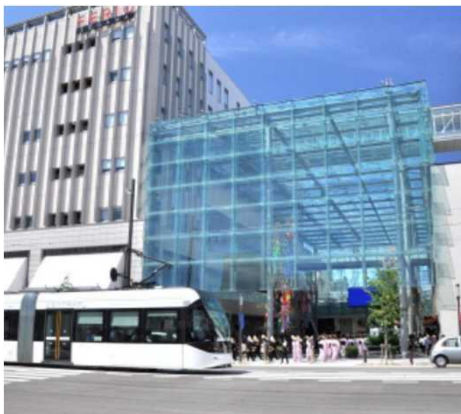
[市内中心部賑わい拠点の整備(グランドプラザ)]
