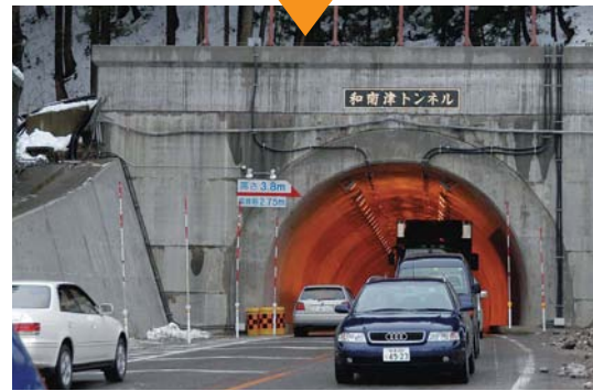
③ 国道17号川口町和南津 トンネル復旧 12月26日14時55分 片側交互通行を解除し、2車線で通行確保
