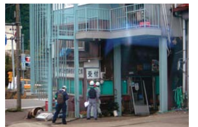
被災建築物の応急危険度を判定(川口町)
