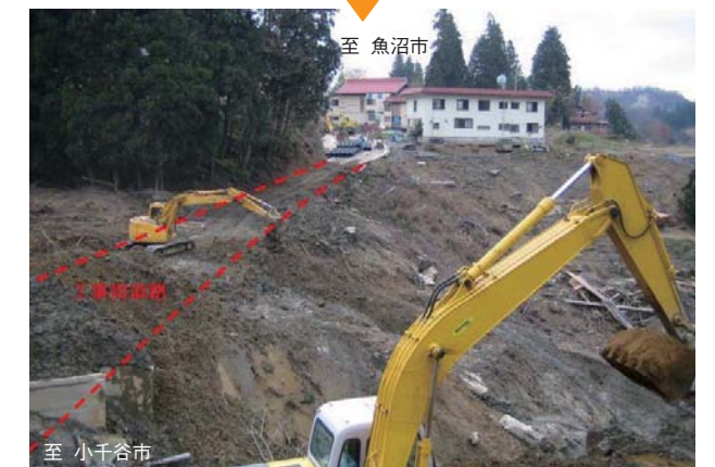
④ 山古志村梶金集落入り口 工事用道路を施工中
