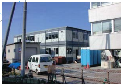
③ 小千谷税務署の仮庁舎の建設状況(右側が本庁舎)
