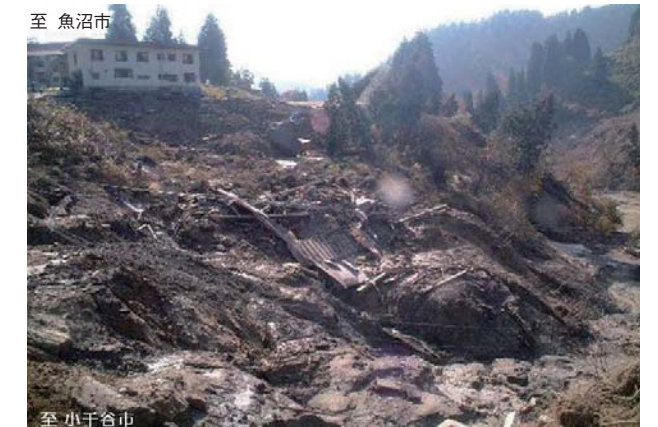
④ 山古志村梶金集落入り口 土砂崩落
