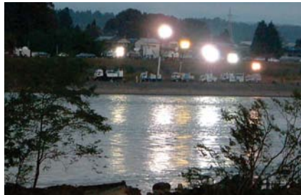
土砂崩落現場の対岸からの照明活動
