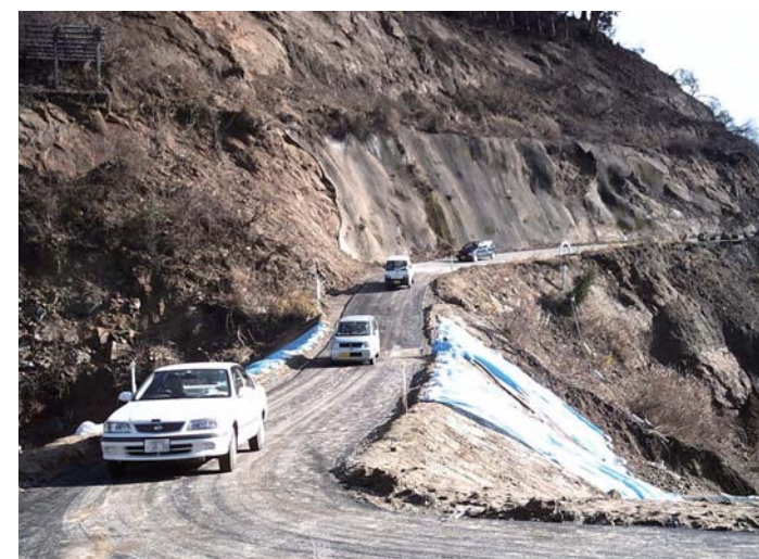
⑤ 整備が完了した工事用道路(梶金地区の車両搬出の様子) (平成16年12月5日)
