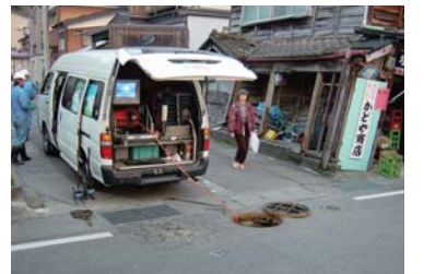
下水道管路内TVカメラ調査の状況(川口町)
