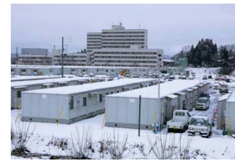
小千谷市千谷に建設された仮設住宅
