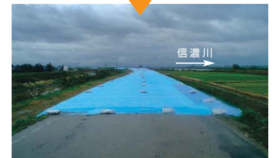
① 中之島町長呂緊急復旧完了 亀裂の発生箇所を掘削、盛土、シート張りによる緊急復旧を実施(11月3日 17時完了)
