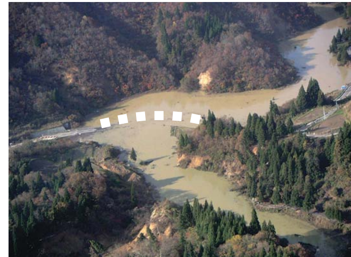
② 山古志村東竹沢 芋川の河道閉塞により水没した新宇賀地橋付近
