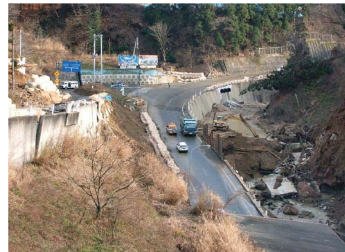
③ 小千谷市小栗山 応急復旧完了(平成16年12月20日)
