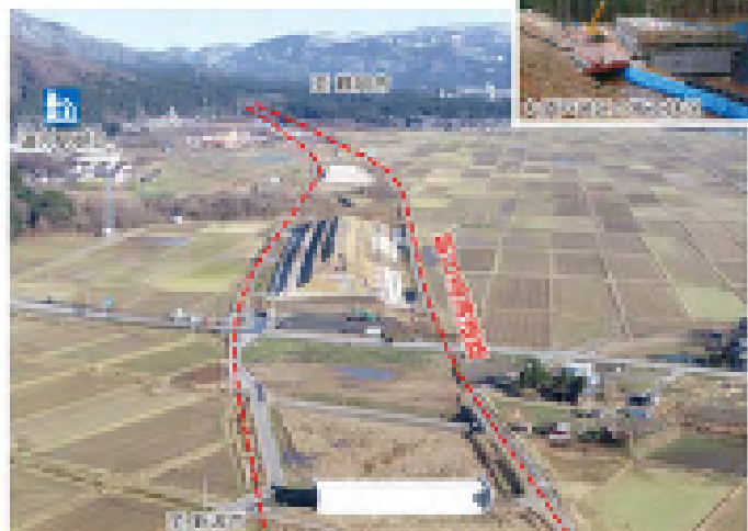
高速ネットワーク形成による日本海側に沿った交通の連携強化、夏津地区へのアクセス性向上を目的とした新幹線道路（日本海側平島交差点から新幹線まで一部を構成）（新潟県川上市）
