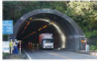
点群にポイントを利用したトンネル点検
