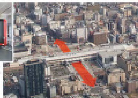
駅の南北一体化（立体交通）により都市機能の強化を図る新潟駅付近連結立体交差事業（新潟県新潟市）
