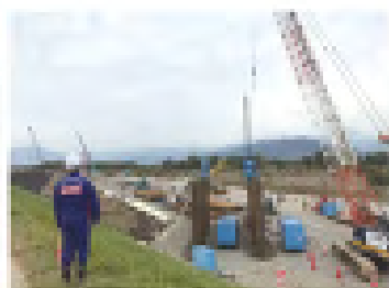
24時間体制で緊急復旧工事(新潟県佐和田町建設課)
