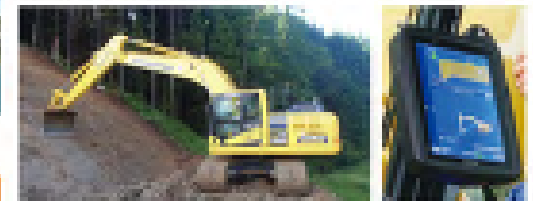
ICT建設機械による土工(正面撮影)
