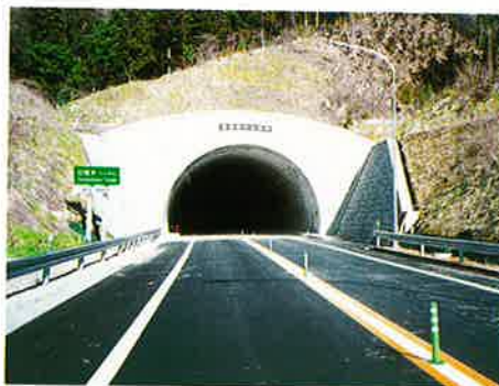
田鶴浜トンネル NATM工法 L=600m
