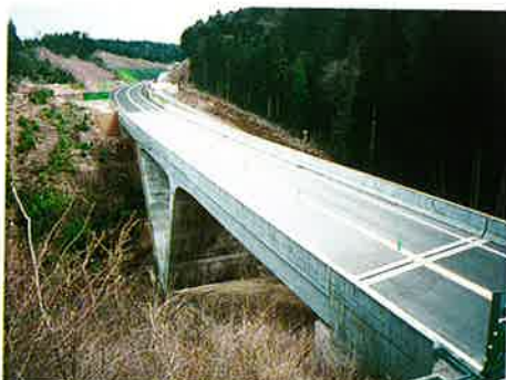
深見橋 3径間連続RC中空床版V脚ラーメン橋 L=80.0m
