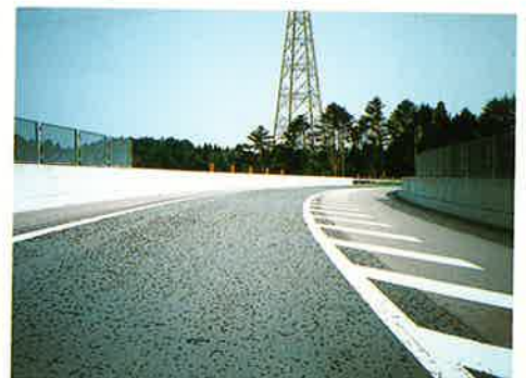
加賀山橋 ゴム骨材入アスファルト(路面凍結対策工法) L=269.0m
