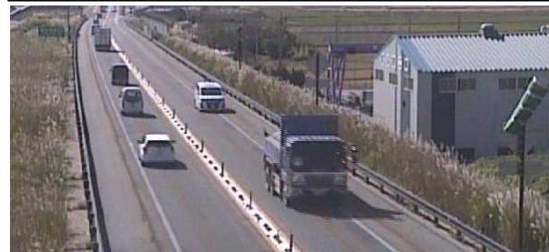
[写真②. 2車線区間(盛土部)]
