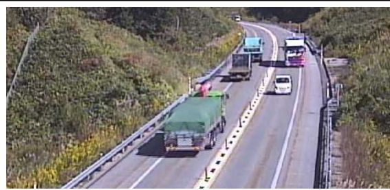
[写真③. 2車線区間(切土部)]
