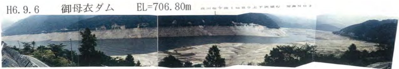
平成 6 年渇水時の御母衣ダム
