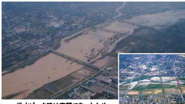
洪水ピーク時は夜間であったため、 写真は減水時のもの 普段の庄川の様子(平成15年5月)
