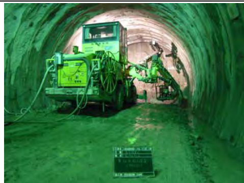
3工区トンネル施工状況
