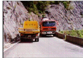
一般国道471号(現道)
