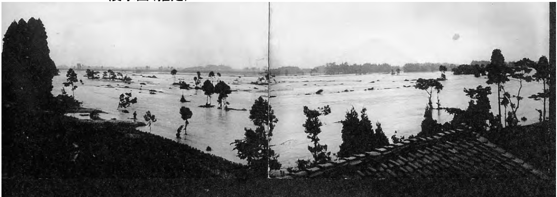
7月14日 大門町(現射水市)島(庄川右岸)より庄川方面
