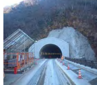
現在、施工中の利賀ダム工事用道路
