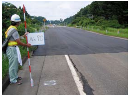
写真2-2-32 段差をすりつけ開放(柏崎市西山町田沢)
