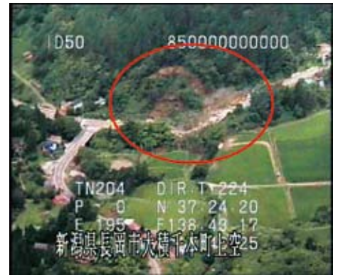
写真2-5-8 国道8号の被災状況 (長岡市大積千本町地先、円内が災害箇所)
