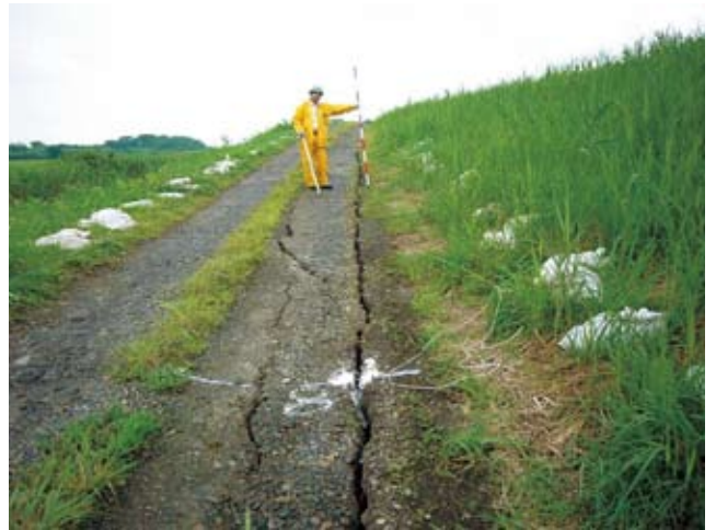
写真2-1-8 堤防亀裂
