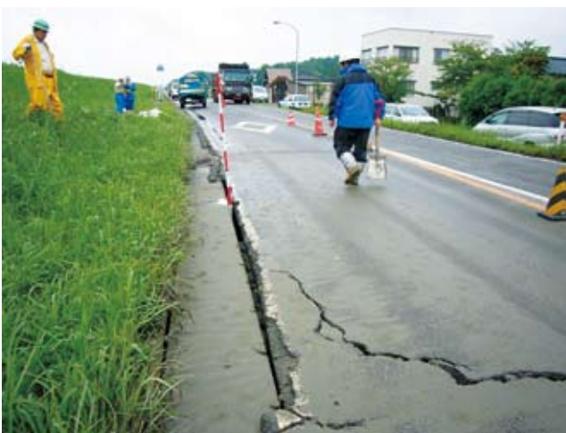
写真2-1-9 堤防亀裂
