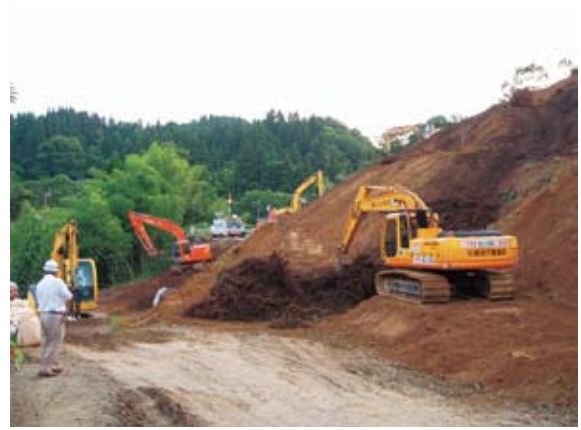
写真2-2-18 切土施工状況(長岡市大積千本町)
