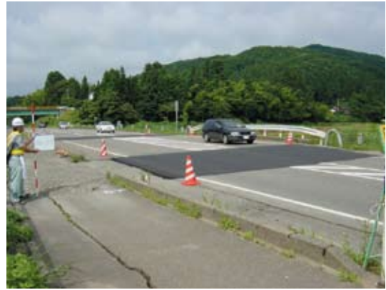
写真2-2-30 段差をすりつけ開放(藤掛川橋)
