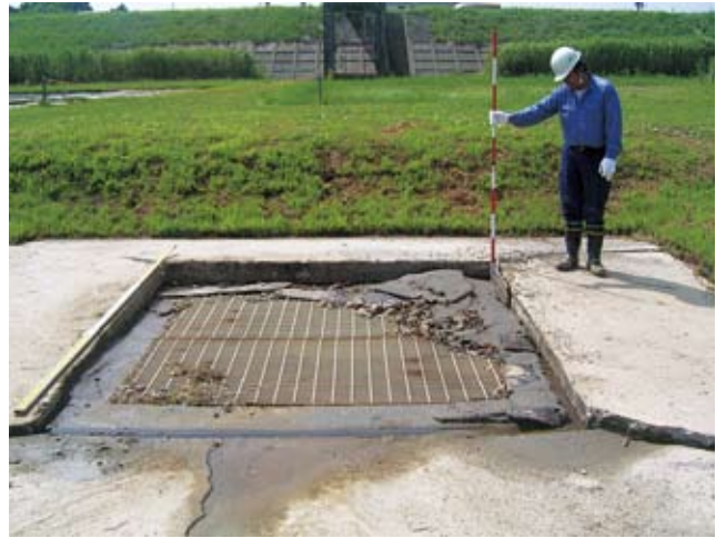
写真2-1-6 沈下・噴砂跡
