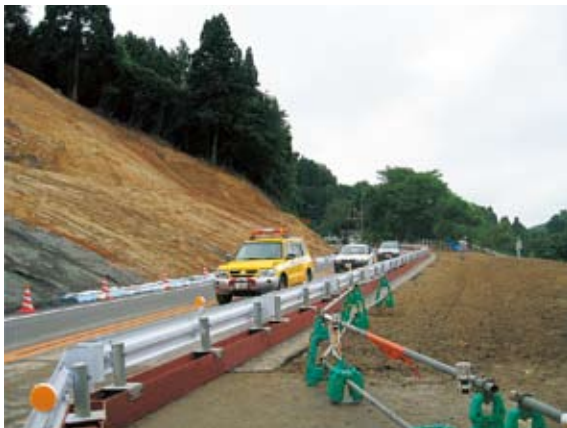
写真2-2-19 応急復旧完了・開通(長岡市大積千本町) (H19. 7. 23 9:00)
