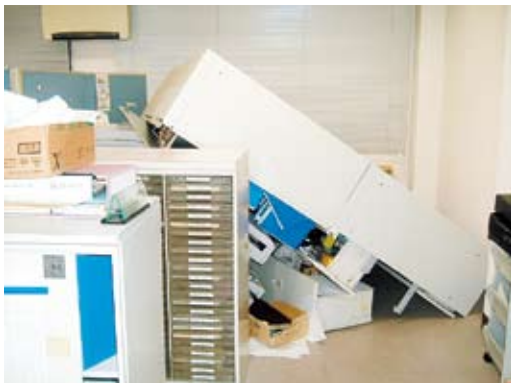
写真2-6-3 柏崎維持出張所執務室の書庫が転倒しFAXが使用不能な状況
