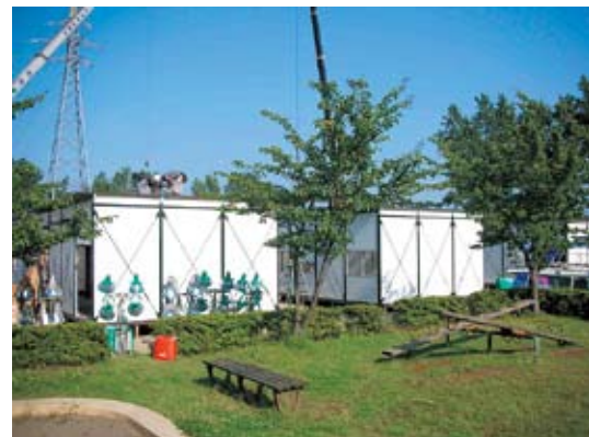
写真2-3-16 仮設住宅建設状況(柏崎市駅前公園)
