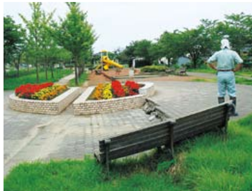
写真2-3-14 大久保緑道(水道橋公園) (花壇・ベンチの破損)
