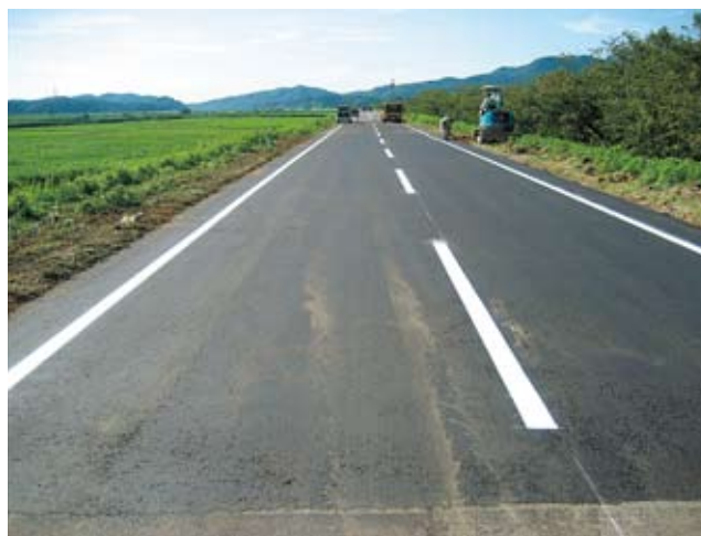
写真2-1-14 応急復旧完了
