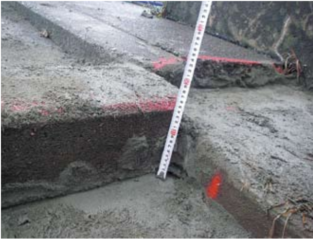
写真2-1-5 護岸沈下
