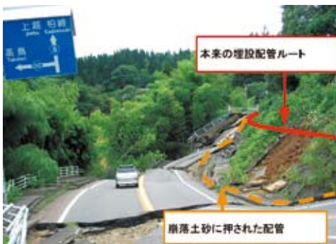
写真2-5-9 本来の配管ルートと被災後の位置
