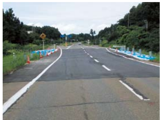
写真2-2-34 段差をすりつけ開放(柏崎市西山町尾野内)
