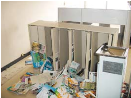
写真2-6-5 信濃川河川事務所広報スペースの書庫の転倒状況
