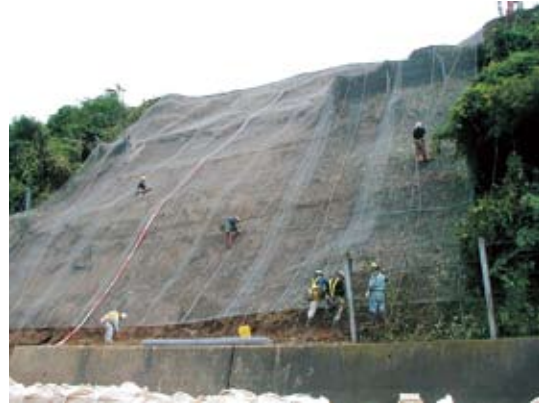
写真2-2-22 落石防止用ネット施工状況(上越市長浜)
