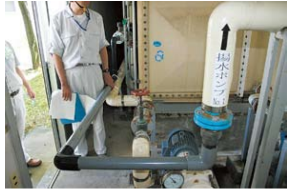
写真2-3-25 新潟県営松波町住宅(公営)受水槽パイパス仮配管
