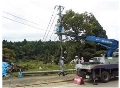
写真2-5-12 国道8号光ファイバケーブル応急復旧状況
