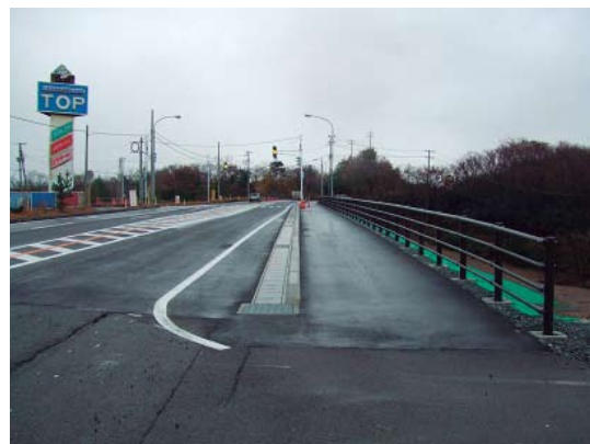
写真2-2-28 復旧完了(柏崎市鯨波)
