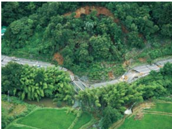
写真2-2-1 道路崩壊(国道8号長岡市大積千本町)
