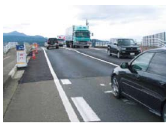
写真2-2-26 段差をすりつけ開放(比角跨線橋)
