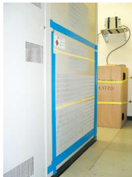
写真2-5-3 レーダ送受信装置の背面扉部を粘着テープ及び梱包用結束バンドにて仮固定した様子
