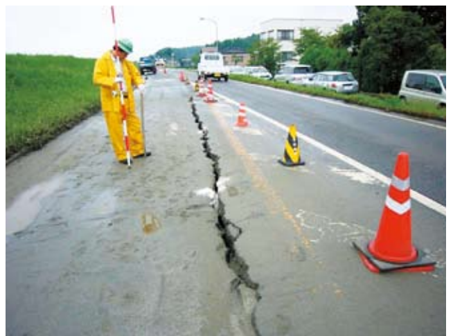
写真2-1-10 堤防亀裂
