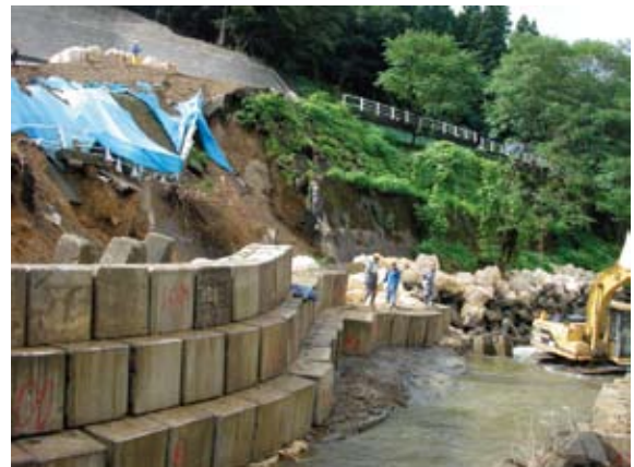
写真2-2-20 黒川の浸食防止対策(長岡市大積千本町)
