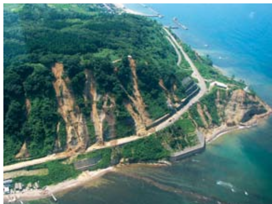
写真2-2-4 法面崩落(国道352号柏崎市椎谷)
