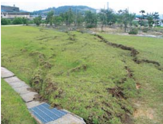
写真2-3-9 鯖石川改修記念公園 (芝生広場の亀裂)
