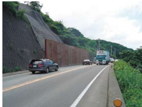
写真2-2-24 応急復旧完了・開通(上越市長浜) (H19. 7. 31 12:00)
