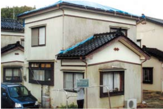
写真2-3-24 出雲崎町営大門住宅(公営)瓦屋根損傷の 応急復旧
