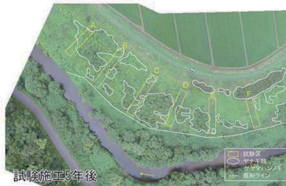
平成22年度 試験施工地
