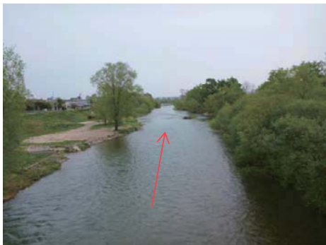
施工前（鮎見橋下流側）
