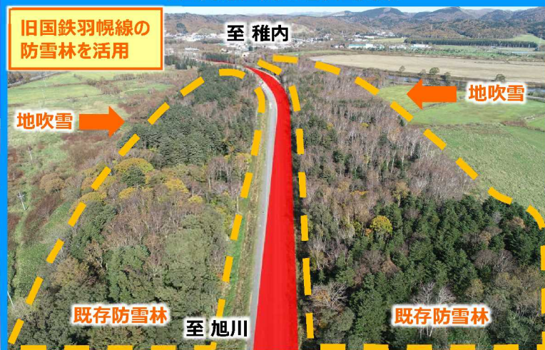
今回開通区間の地吹雪対策
