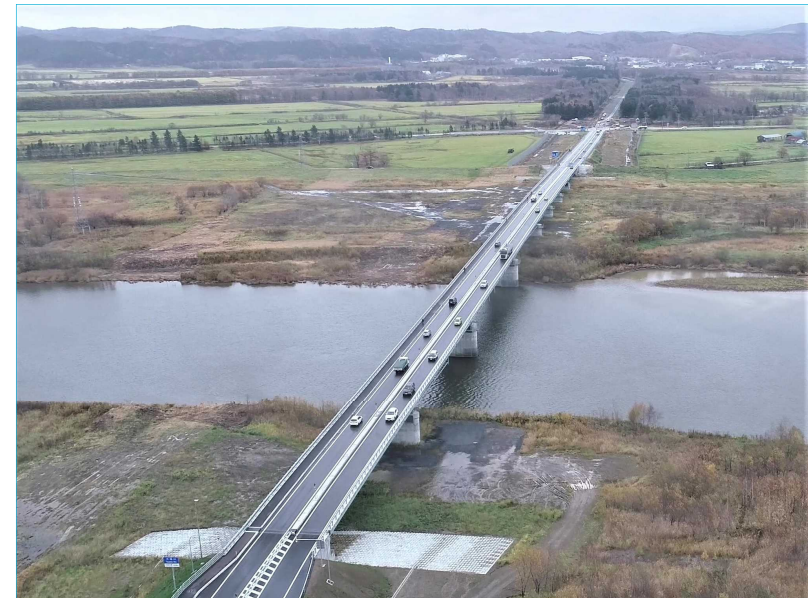
【天塩大橋 開通状況(令和2年10月)】
