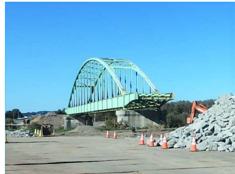
【旧天塩大橋 撤去状況(令和4年9月)】
