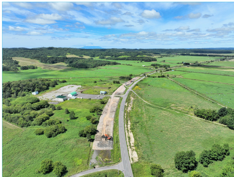
【地盤改良工 施工状況 全景(令和4年8月)】
