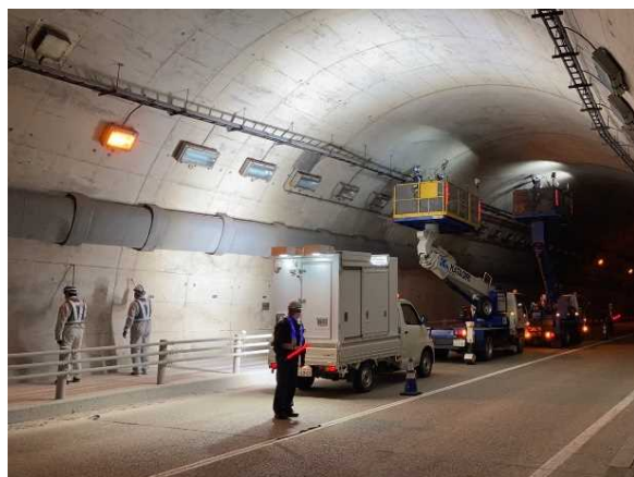
一般国道5号 大沼トンネル（下り）（七飯町）
