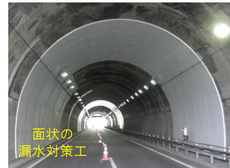
写真－面状の漏水対策工（防水パネル工） ※断熱材付き面型パネルによる漏水対策
