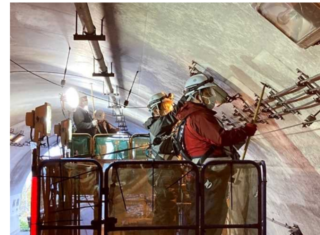
写真一近接目視によるトンネル点検状況
