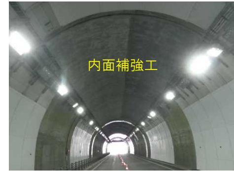
写真－内面補強工（格子筋補強工） ※ポリマ-セメントモルタル+格子鉄筋による増厚補強
