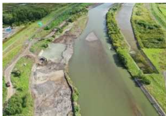
河道掘削状況（渚滑川）
