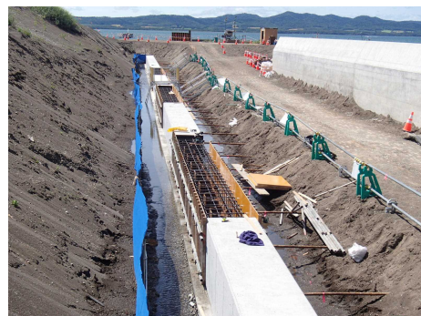
サロマ湖地区 護岸（航路東）状況
