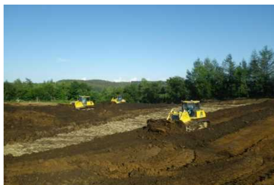
区画整理工事中の津別地区
