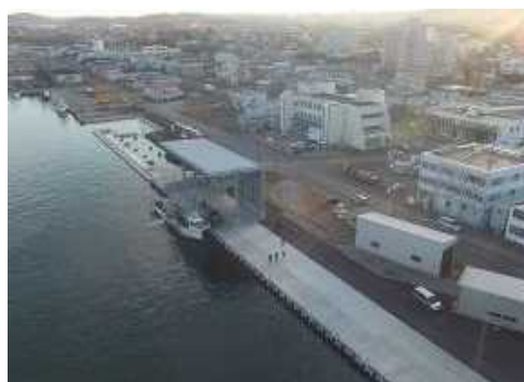
港町地区水深4.0m西物揚場改良
