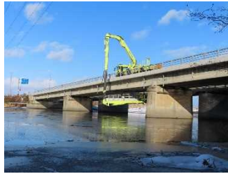
橋梁の点検状況
