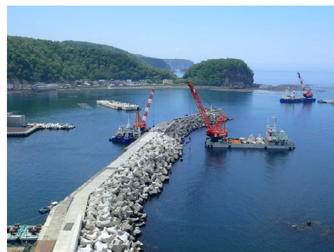
ウトロ地区 西防波堤（改良）
