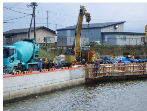
川筋地区水深3.0m物揚場改良
