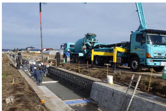
用水路工事中の網走川中央地区
