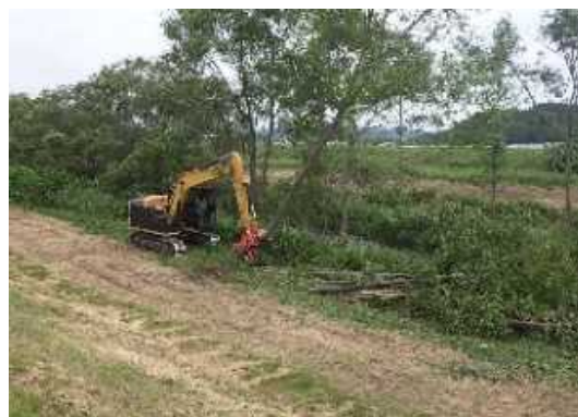
樹木伐採状況（網走川水系美幌川）
