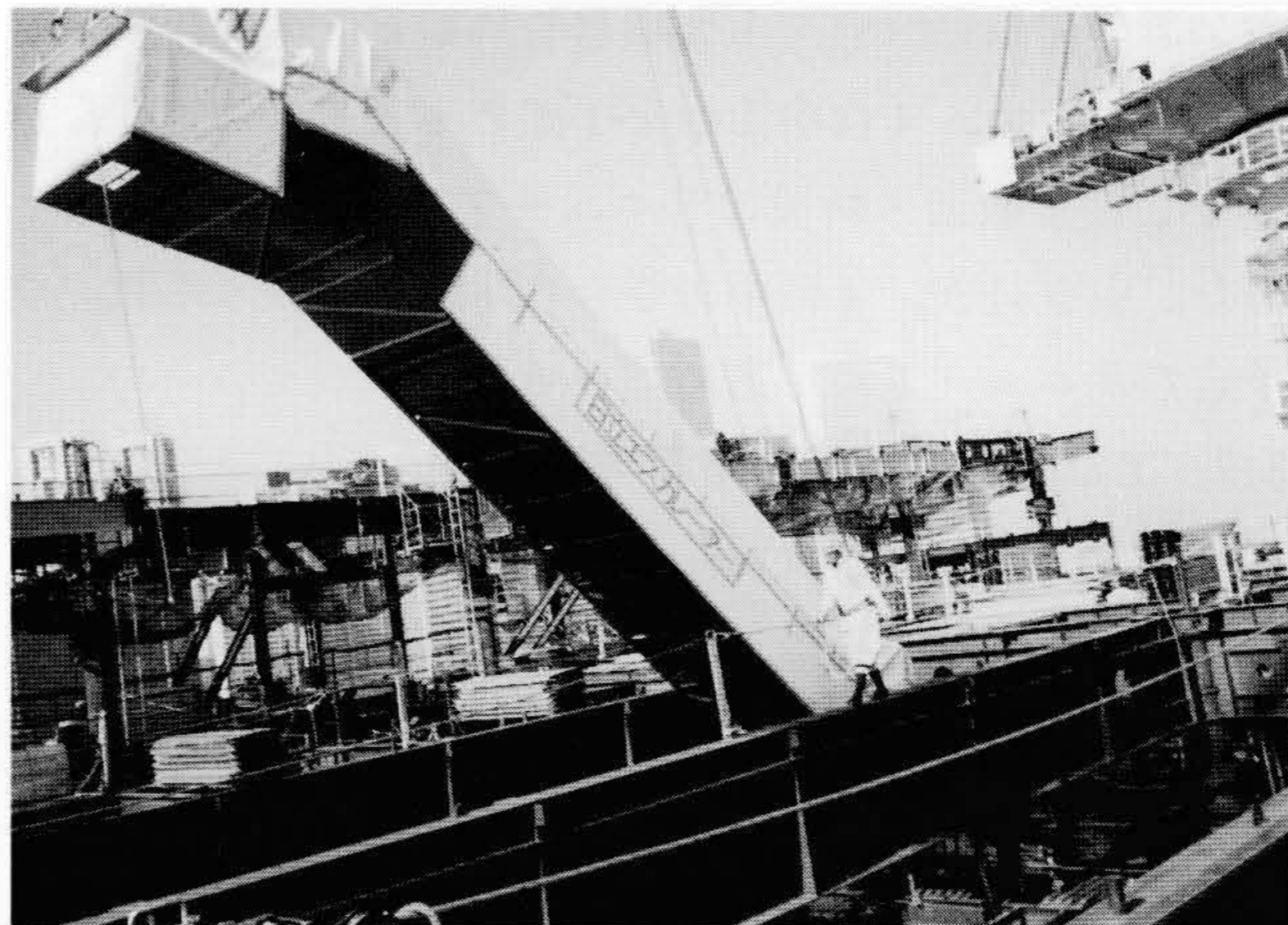
図3 エスカレーターの空中搬入方式
