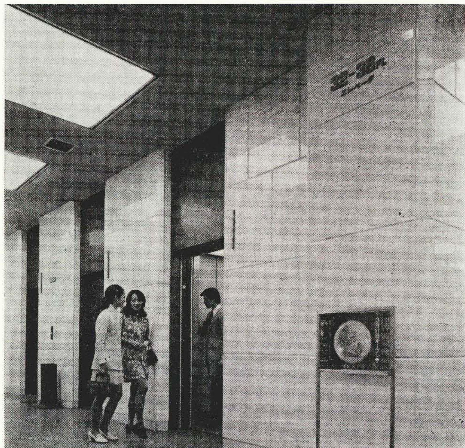
図 11 世界貿易センタービル納 300 m/min エレベータホール
