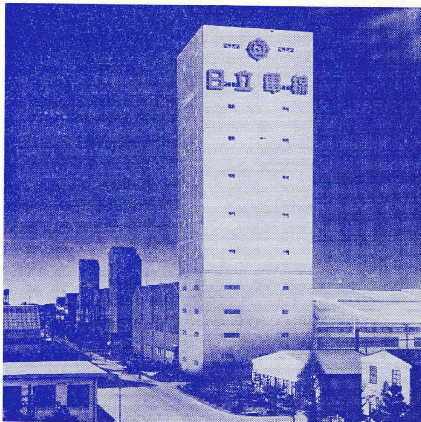
図8 稼働にはいった加硫塔
