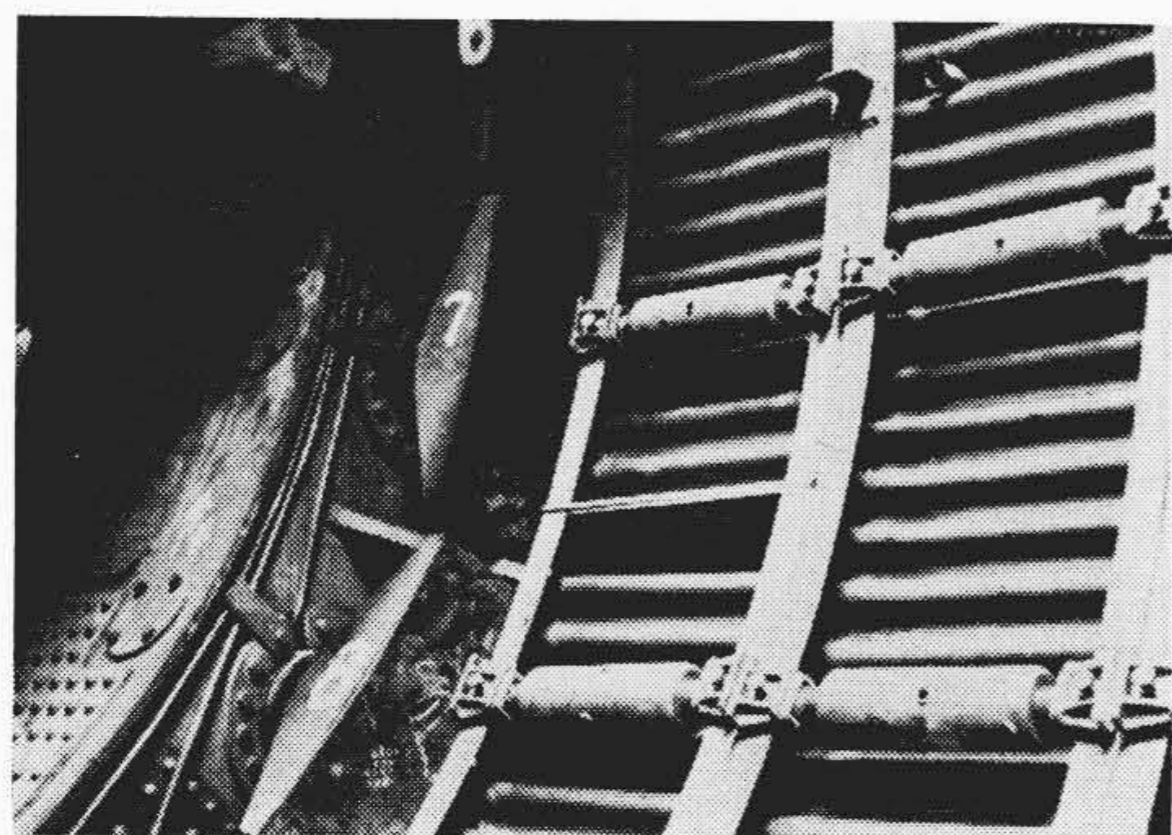
第13図 シールド・セグメント組立完了
