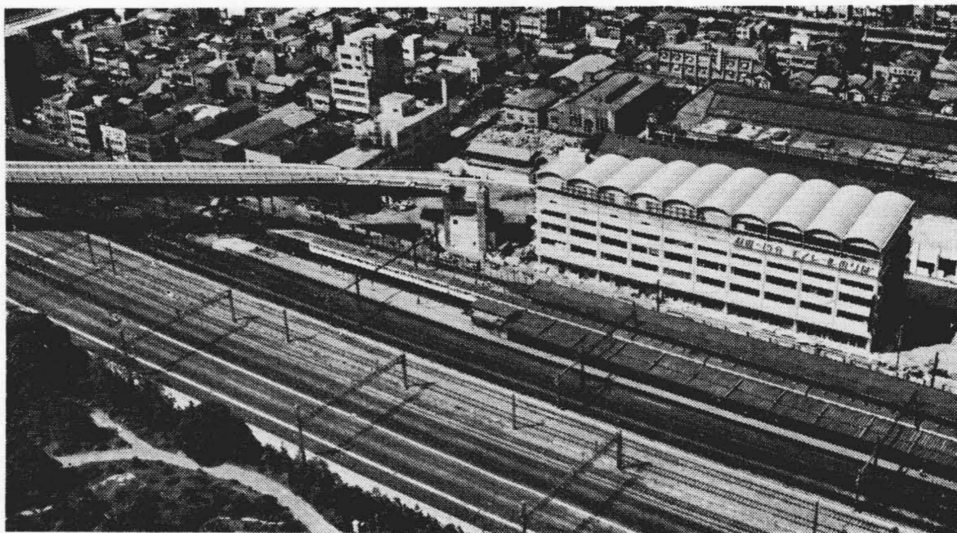
第15図 モノレール浜松町駅と国鉄横断橋りょう
