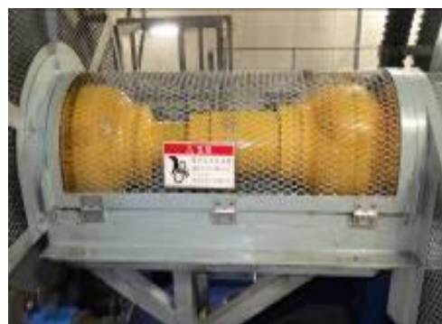
原動ユニバーサルジョイント交換
