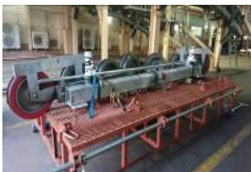
支柱受索装置整備
