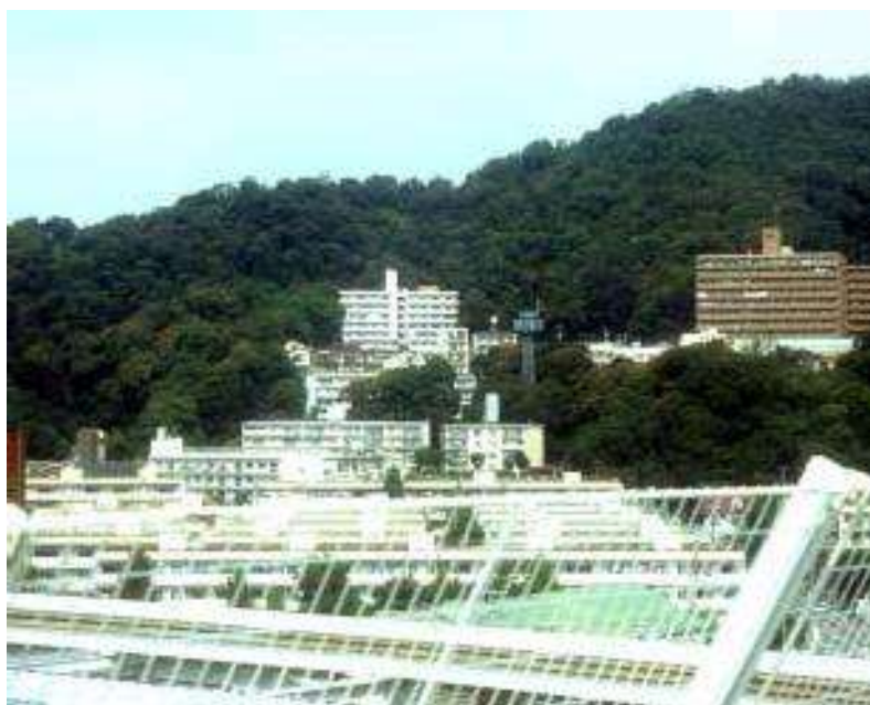
JR広島駅新幹線屋上駐車場から見たトンネル坑口計画付近
