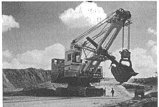
写真7 巨大なパワーショベル。
