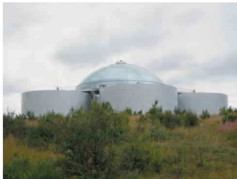
写真7 レイキャピクを見下ろす丘にあるペルトラン (Perlan)、郊外の地熱発電所からの温水をタンクに貯めて、市内の各家庭に送っている。「真珠」を意味する複合施設には、博物館などもある。
