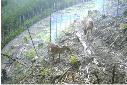
シカ防護柵の設置
