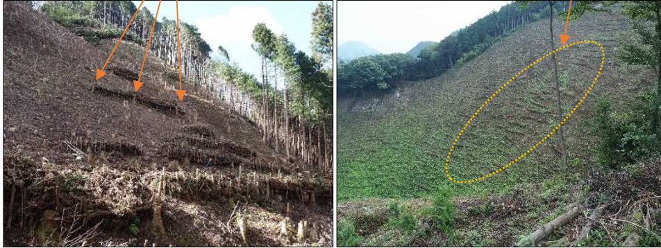
柵積みの例（等高線に沿って配置）
