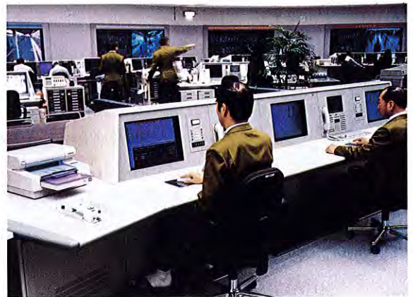
総合指令所 Integrated control center
