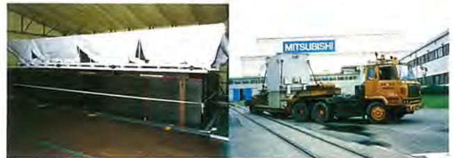
(a) 鉄心組立完了後のCGPA変圧器(組立ハウス内)
