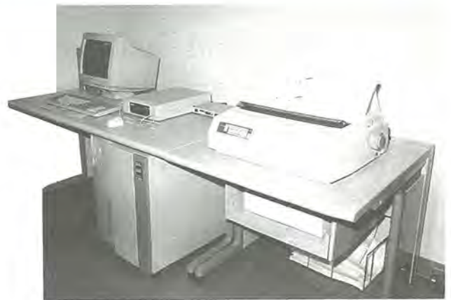
遠隔監視制御装置
