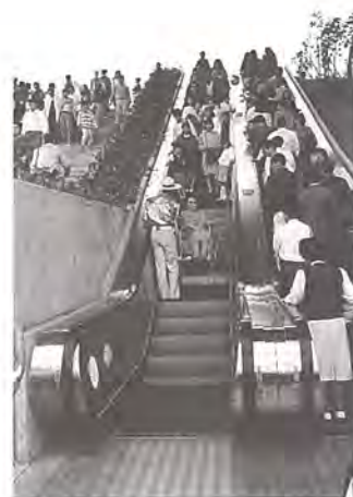
車いす使用者・健常者同時利用形車いすエスカレーター
