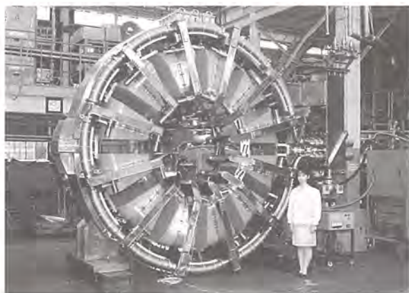
工場試験完了後の超電導トロイダル電磁石
