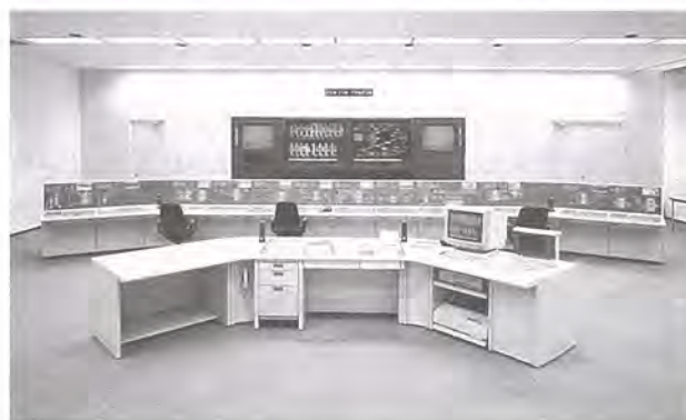
村野浄水場送水管理センター
