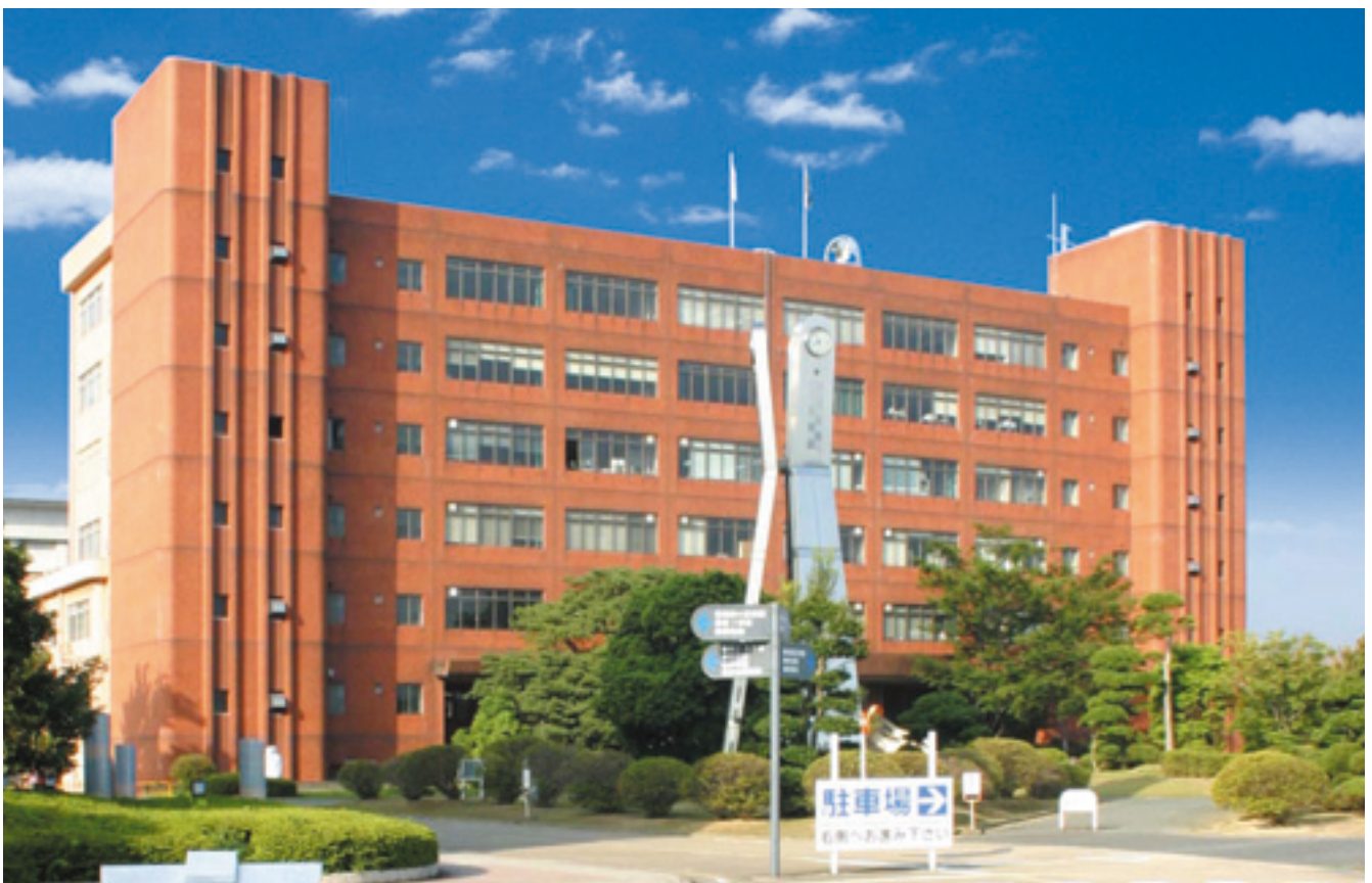
■ 西第一学舎(大学本館)
