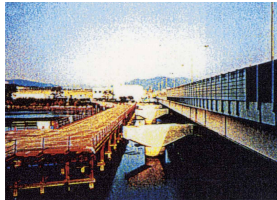
写真3-2-6 宇美川付近工事状況
