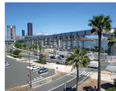
上部工施工時(令和元年6月)
