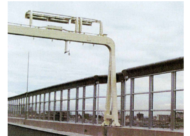
写真3-2-9 防音壁と特殊吸音装置
