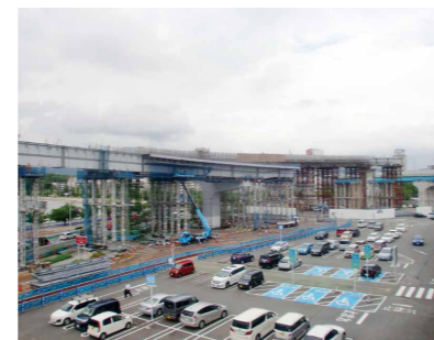
上部工施工時(令和元年7月)
