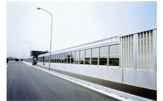
写真3-2-4 特殊吸音装置付き透光板
