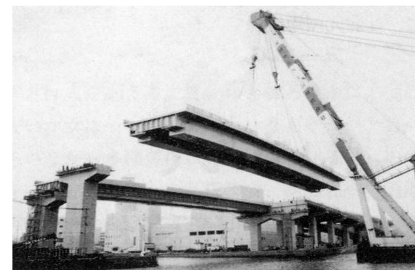
写真3-1-3 博多船溜り橋梁架設工事
