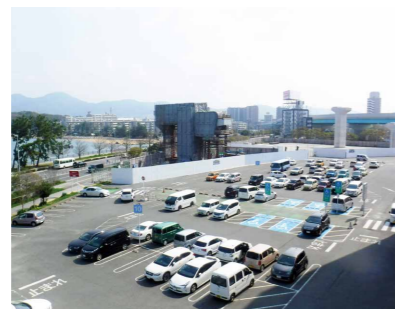
下部工施工時(平成31年3月)
