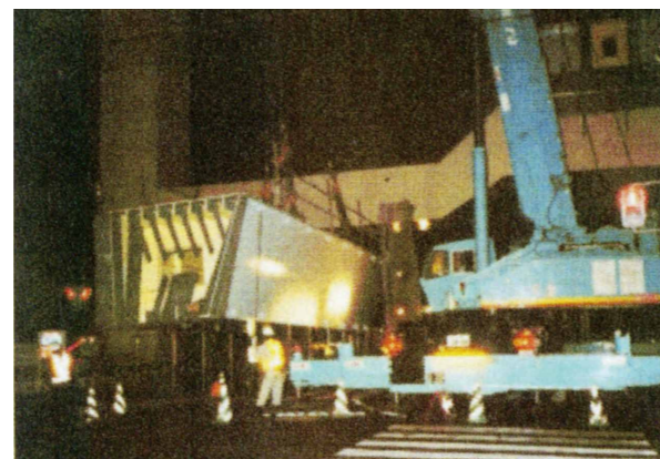
写真3-2-8 下山門~福重間の工事状況
