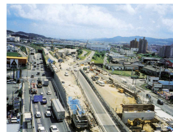
写真3-2-2 太宰府IC連結、水城出入口工事状況
