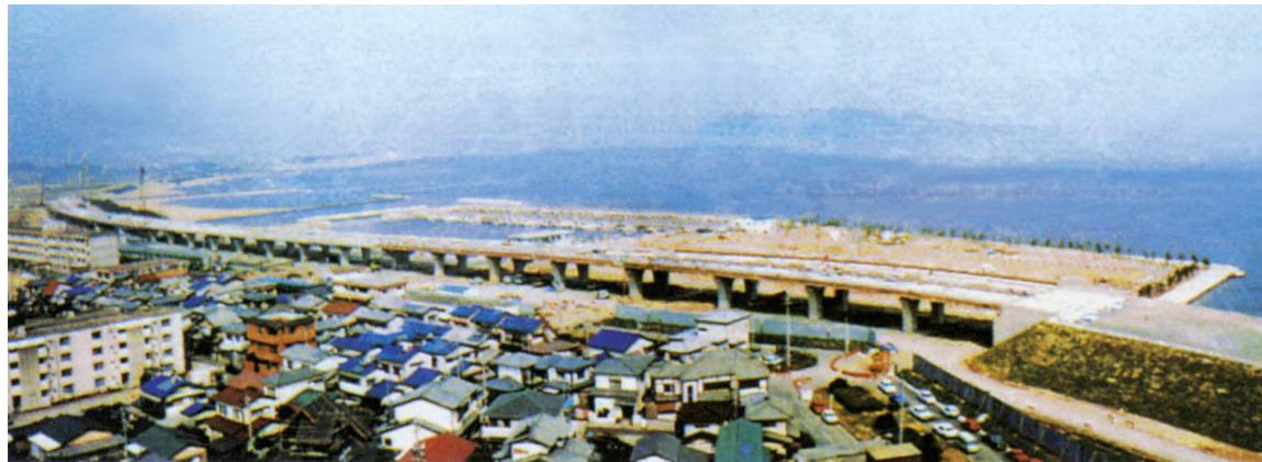
写真3-1-6 橋面と盛土完成
