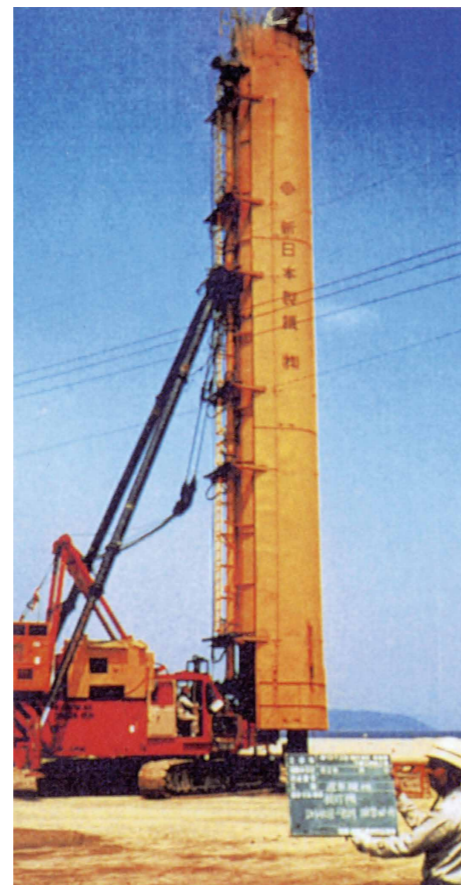
写真3-1-8 ディーゼルパイルハンマーで鋼管杭施工中
