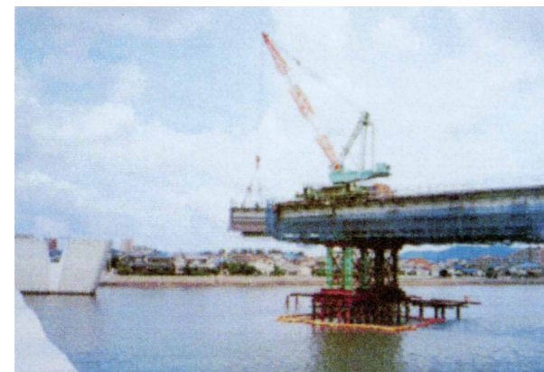
写真3-2-7 室見川工事状況
