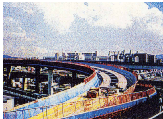
写真3-2-5 貝塚JCT渡り線工事状況
