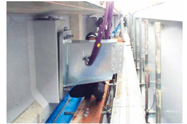
写真3-4-10 Aライン施工状況(ブラケット設置)
