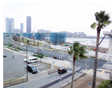
下部工施工時(平成30年12月)
