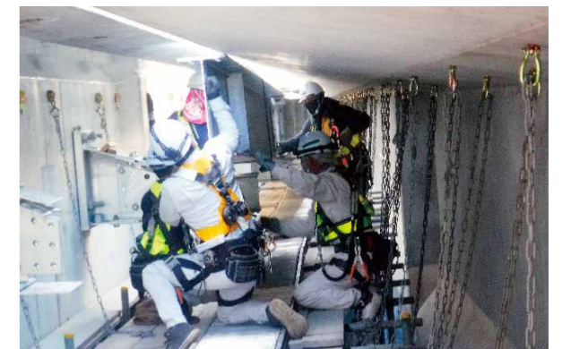
写真3-4-11 Bライン施工状況(縦桁設置)
