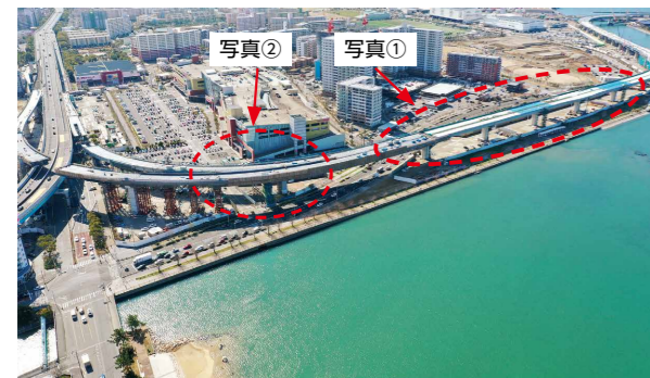
施工中(令和2年2月) 写真3-4-4 全景
