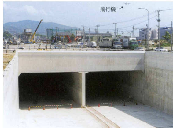
写真3-2-1 ボックスカルバート(トンネル)完成
