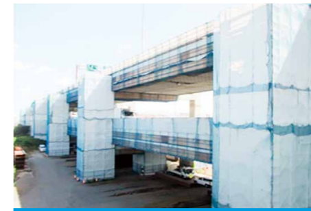
老朽化・予防保全対策工事 着手(2012.7.10)
