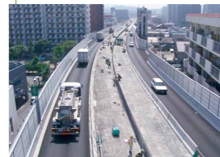
4号線 大規模補修工事 完了(2009.3.31)
