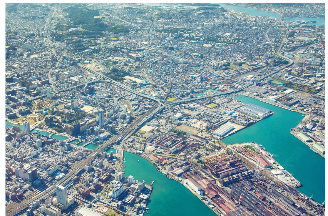
2号線小倉駅北から若戸大橋・3号線・愛宕JCT方面
