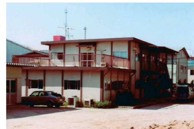
福岡事務所 設置(1978.8.30)
