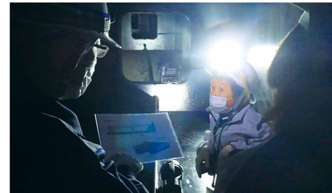
橋梁の桁内点検
