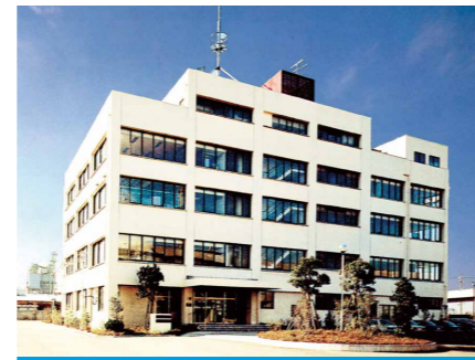
福岡事務所 新社屋へ移転(1980.4.13) 本社 新社屋へ移転(1981.10.12)
