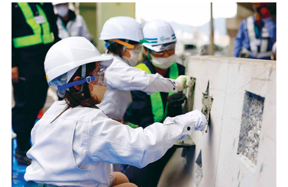
コンクリート補修作業
