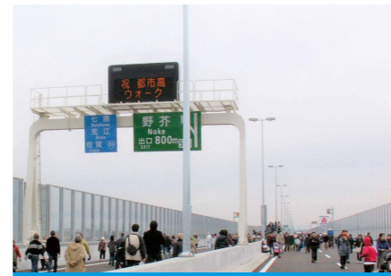
西九州自動車道と接続(5号線)(2011.2.26)
