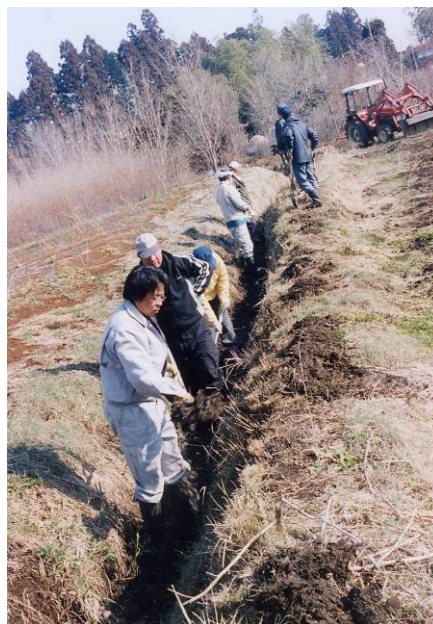
末端水路の浚渫
