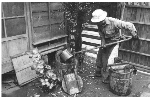
写真 1.4-1 手作業によるし尿汲み取りの例 1)
