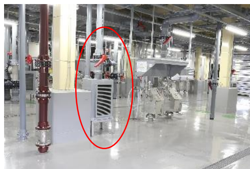
(し尿処理アーカイブス検討会資料) 写真 1.5-7 排気ガス専用捕集口の例 6)
