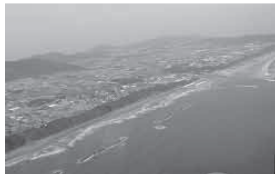
遠州灘海岸 赤羽根漁港付近 砂が漁港にたまるのを防ぐために設置された突堤の影響で、隣接する海岸の侵食が進み、その侵食を防止するために次々と離岸堤が設置されている。
