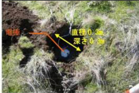
埋設前の状況
