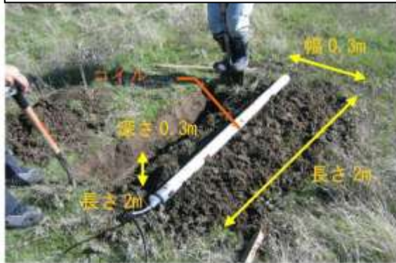
コイルの埋設状況
