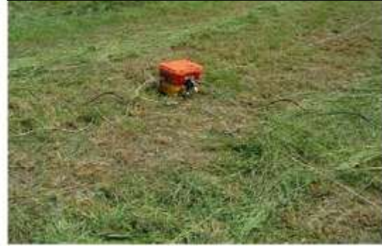
電線と受信機の設置状況
