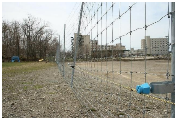
ウトロ市街地に設置されている侵入防止柵
