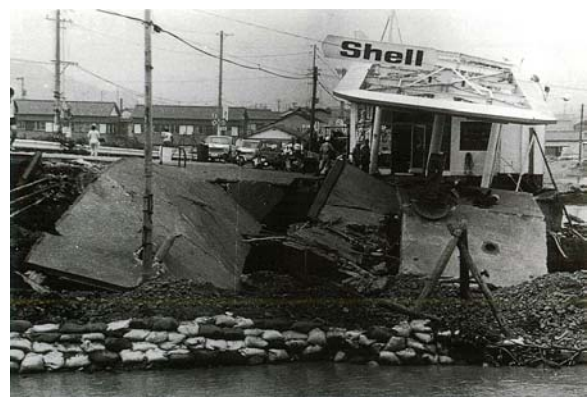
図 1-17.長尾川の決壊（長尾川橋上流右岸側） 出典：記念誌「大谷川放水路」
