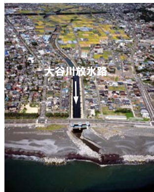
図 1-19.大谷川放水路
