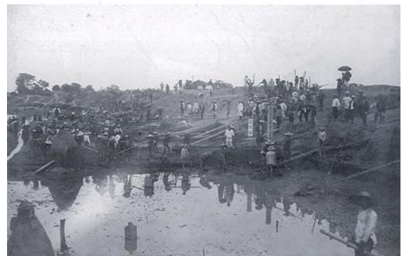
図 1-14.巴川河身改修工事（明治 43 年） 出典：上土誌
