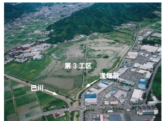
図 1-20.出水時の麻機遊水地（第 3 工区） (撮影：H15.7.4)
