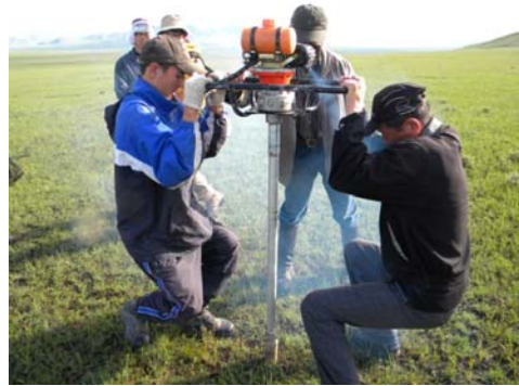
ボーリング の様子
