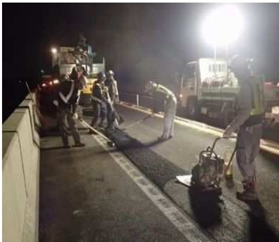
通行止めによる舗装補修工事
