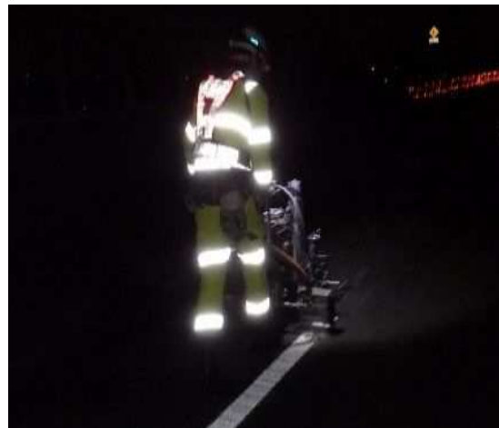
通行止めによる維持工事
