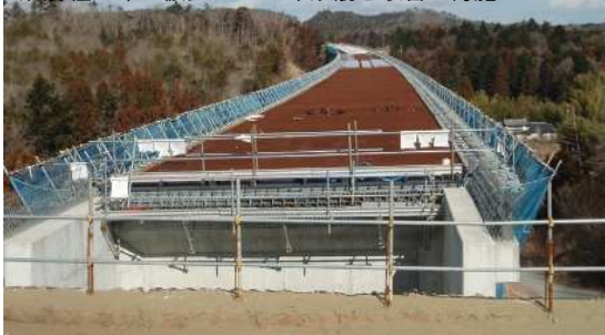
常磐富岡～浪江間 工事再開前の状況
