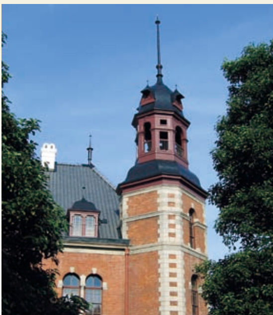
② 竣工後のクラーク記念館
